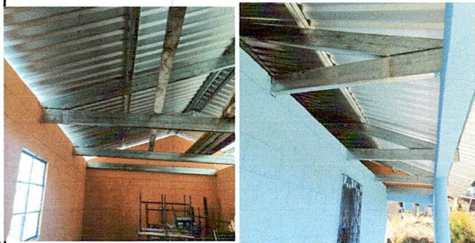
Foto 7: Sustitución de estructura de soporte de madera, por metal
