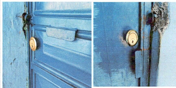
Foto 10: Sustitución de chapas
