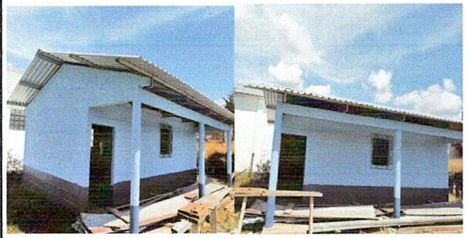
Foto 6: Sustitución de lámina, por lámina troquelada
