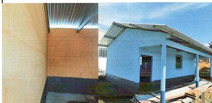
Foto 13: Pintura exterior e interior de aulas
