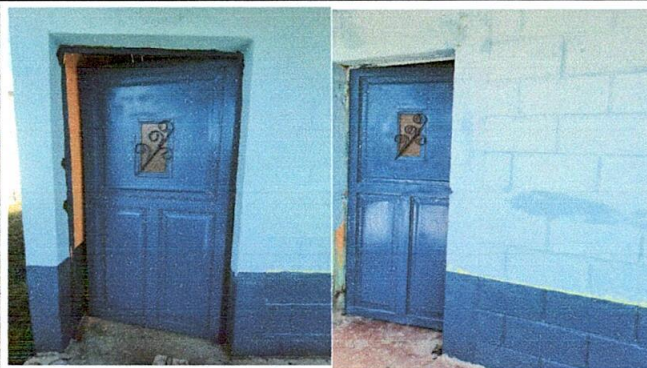
Foto 8: Sustitución de puertas(2 m de alto * 90 cm de ancho)
