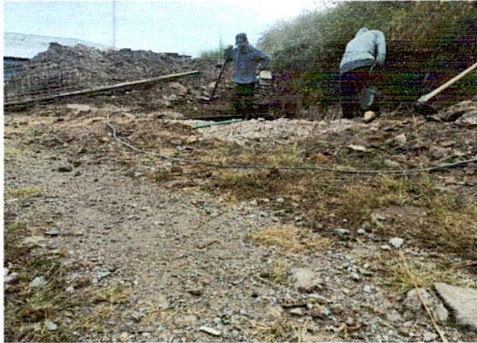
Foto1: Mejoramiento de drenaje
