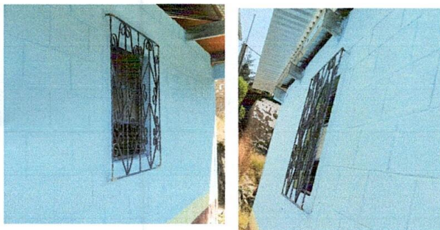
Foto 9: Sustitución de ventanas y mejoramiento de balcones
