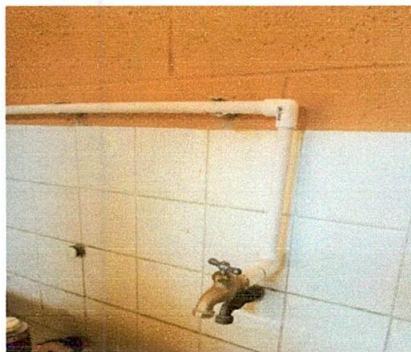
Foto 3: Mejoramiento a estructura de ( tubos, grifos)
