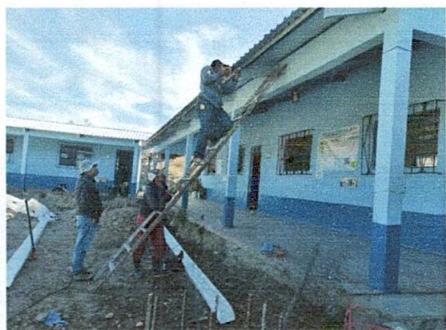
Foto 11: Mejoramiento de canal
