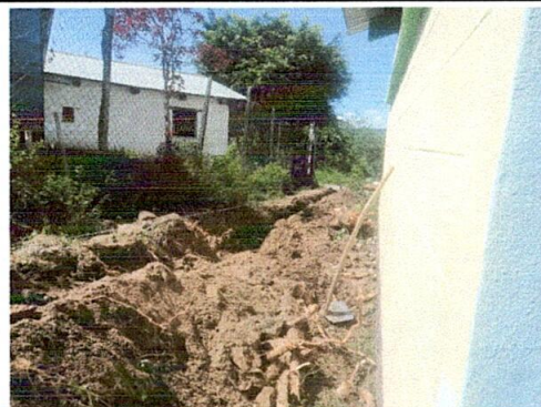
Foto 2: Sustitución de tubería PVC linea principal aguas negras
