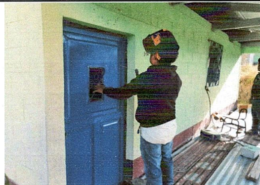
Foto 8: Sustitución de puertas (2 m de alto * 90 cm de ancho)
