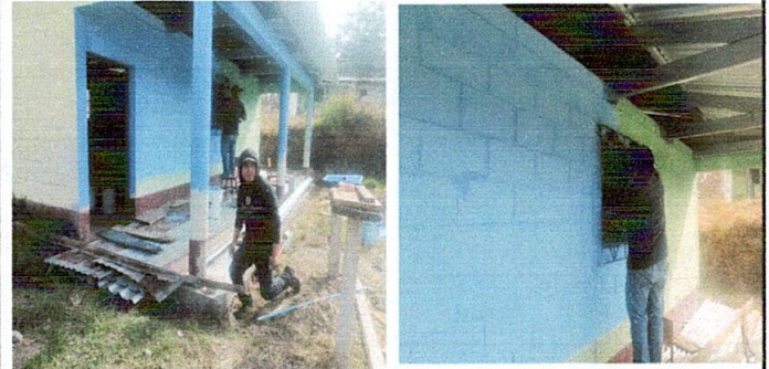
Foto 13: Pintura exterior e interior de aulas
