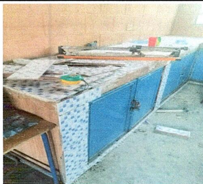
Foto 5: Instalación de azulejo en gabetas y pila de la cocina
