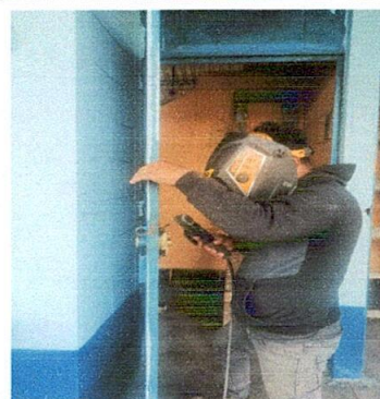
Foto 10: Sustitución de chapas
