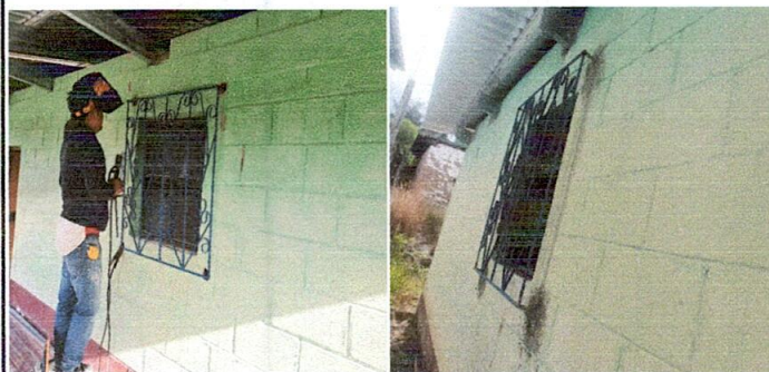
Foto 9: Sustitución de ventanas y mejoramiento de balcones
