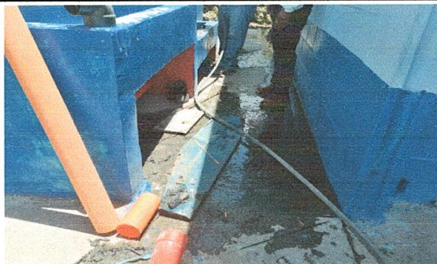
Foto 2: Sustitución de tubería PVC línea principal aguas negras
