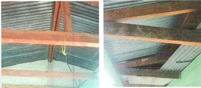
Foto 7: Sustitución de estructura de soporte de madera, por metal
