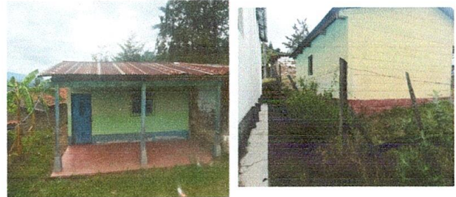
Foto 13: Pintura exterior e interior de aulas
