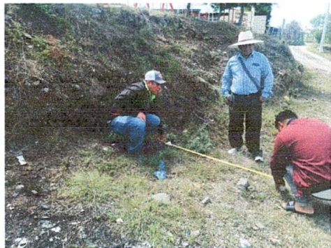
Foto1: Mejoramiento de drenaje
