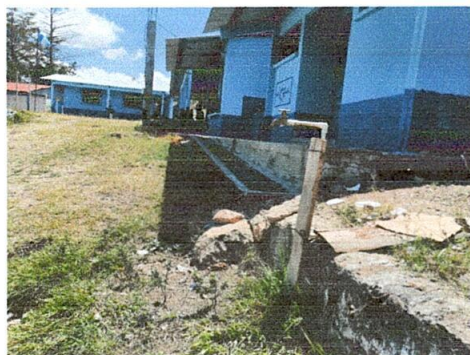
Foto 4: Mejoramiento de pila
