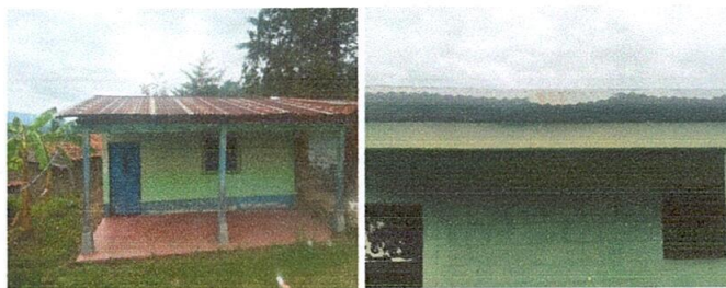
Foto 6: Sustitución de lámina, por lámina troquelada
