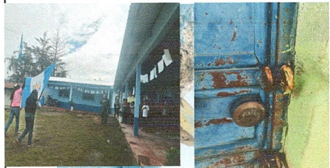
Foto 10: Sustitución de chapas
