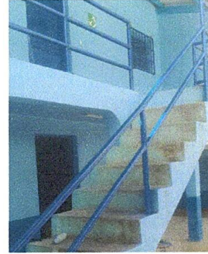
Foto 14: Mantenimiento de baranda de metal
