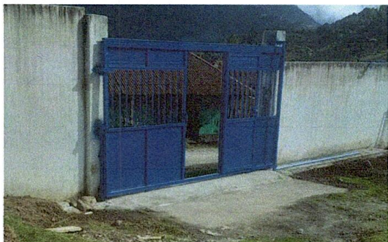
Foto1: Sustrución de portón
