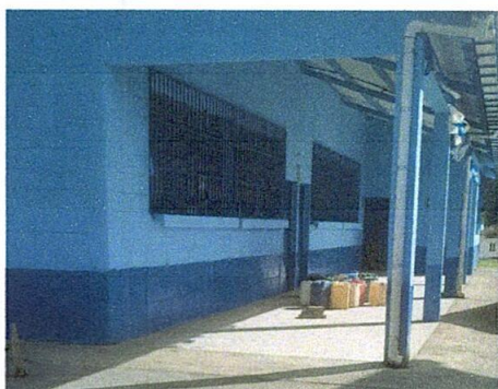
Foto 9: Mantenimiento a Balcones de ventanas (Aulas)
