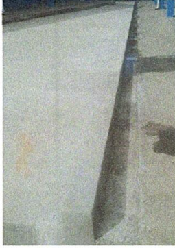
Foto 13: Reparación de banqueta de concreto
