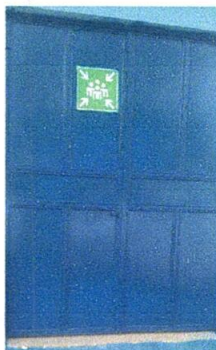
Foto 11: Mantenimiento a puertas demetal
