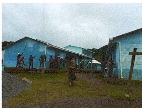
Foto 3: Aplicación de pintura (Modulo I, Modulo II y cocina)
