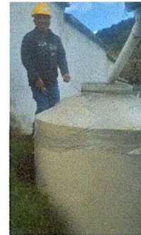
Foto 12: Sustitución de depósito de agua
