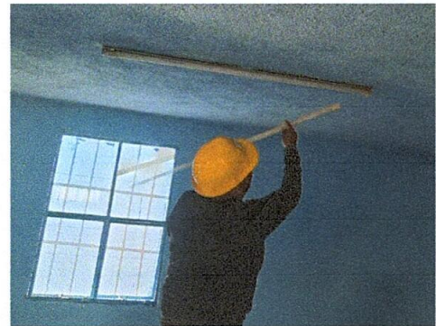
Foto 10: Sustitución de lampara de tubo
