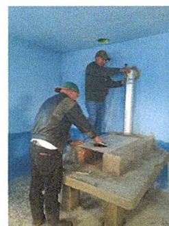
Foto 6: Sustitución de estufa rural completa
