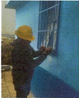
Foto 7: Mejoramiento de Balcones en ventanas (Cocina)
