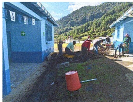
Foto 2: Reparación de cuneta de concreto
