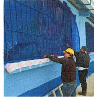
Foto 8: Mejoramiento de Balcones en ventanas (salón)
