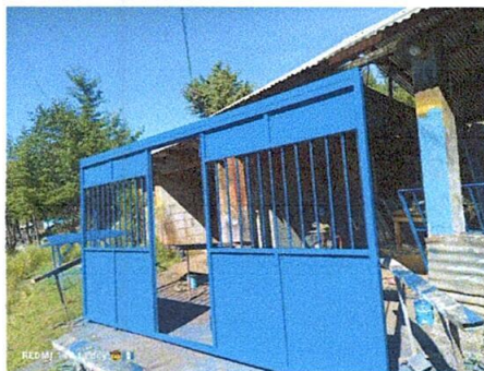
Foto1: Sustitución de portón
