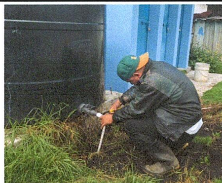
Foto 4: Mejoramiento de tubería línea principal de red Agua Potable
