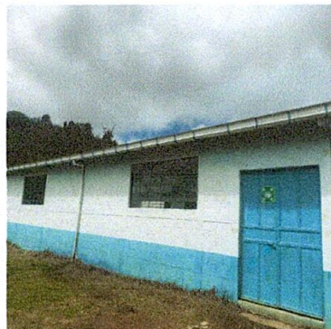
Foto 8: Mejoramiento de Balcones en ventanas (salón)
