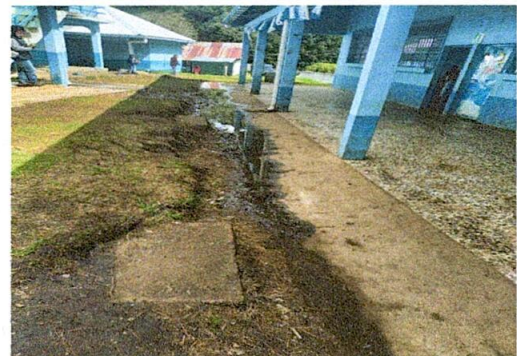
Foto 2: Reparación de cuneta de concreto
