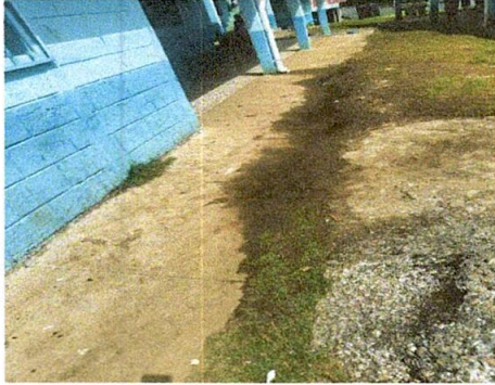
Foto 13: Reparación de banqueta de concreto
