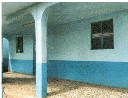
Foto 7: Mejoramiento de Balcones en ventanas (Cocina)
