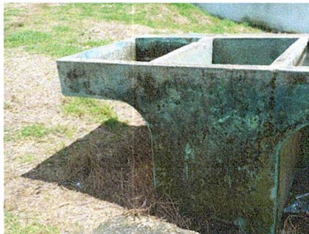
Foto 5: Sustrucción de pila de dos lavaderos
