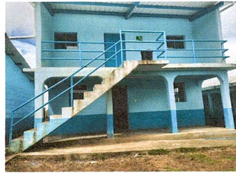
Foto 14: Mantenimiento de baranda de metal
