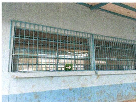
Foto 9: Mantenimiento a Balcones de ventanas (Aulas)
