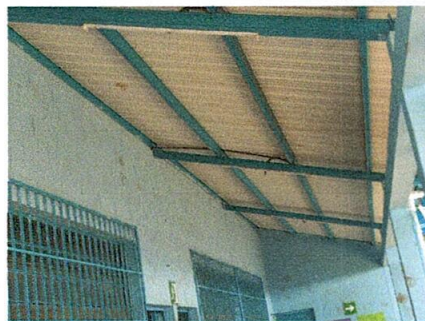
Foto 10: Sustitución de lampara de tubo
