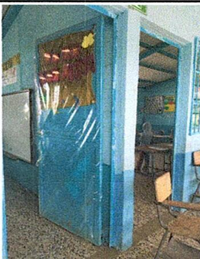
Foto 11: Mantenimiento a puertas de metal
