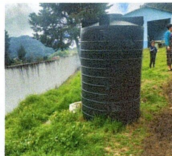
Foto 12: Sustitución de depósito de agua
