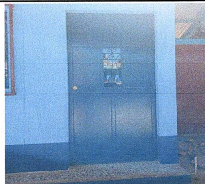
Foto 22: SUSTITUCIÓN DE 3 PUERTAS DE MADERA POR PUERTAS DE METAL
