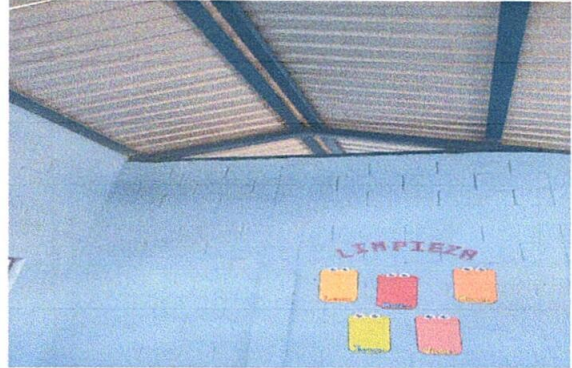
Foto 8: SUSTITUCIÓN DE ESTRUCTURA DE SOPORTE DE MADERA POR METAL
