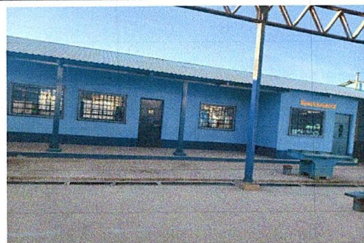
Foto 17: MEJORAMIENTO DE CERRAMIENTO EN AULAS
