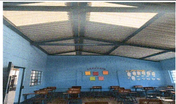
Foto 10: SUSTITUCIÓN DE ESTRUCTURA DE SOPORTE DE MADERA POR METAL
