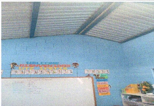
Foto 9: SUSTITUCIÓN DE ESTRUCTURA DE SOPORTE DE MADERA POR METAL
