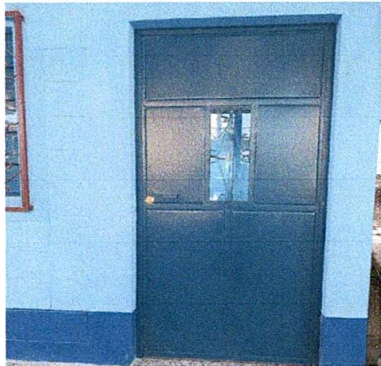
Foto 19: SUSTITUCIÓN DE 3 PUERTAS DE MADERA POR PUERTAS DE METAL
