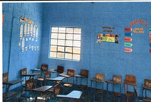
Foto 23: SUSTITUCIÓN DE VENTANAS DE MADERA POR VENTANAS DE METAL Y VIDRIO
