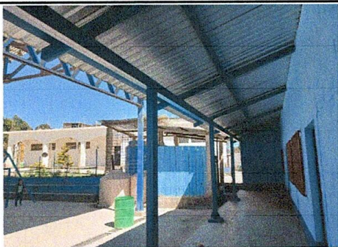
Foto 29: SUSTITUCIÓN DE DEPÓSITO DE AGUA DE 2,500 LITROS
