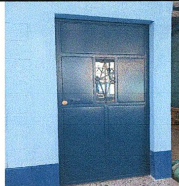
Foto 20: SUSTITUCIÓN DE 3 PUERTAS DE MADERA POR PUERTAS DE METAL
