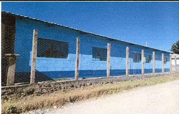
Foto 25: SUSTITUCIÓN DE VENTANAS DE MADERA POR VENTANAS DE METAL Y VIDRIO
