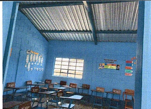
Foto 16: MEJORAMIENTO DE CERRAMIENTO EN AULAS
