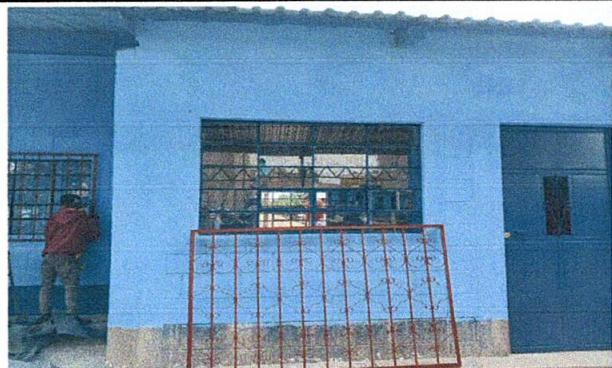
Foto 27: MEJORAMIENTO DE BALCONES PARA VENTANAS DE LAS AULAS
