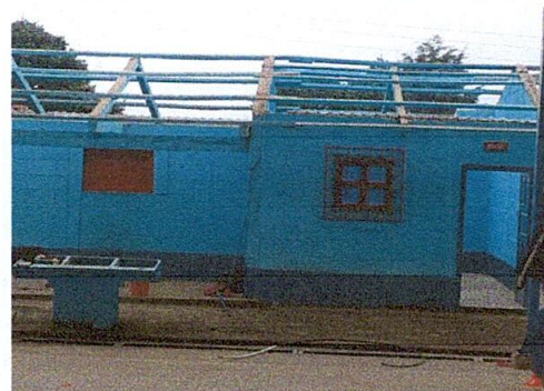
Foto 10: SUSTITUCIÓN DE ESTRUCTURA DE SOPORTE DE MADERA POR METAL
