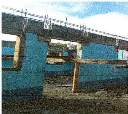
Foto 19: SUSTITUCIÓN DE 3 PUERTAS DE MADERA POR PUERTAS DE METAL
