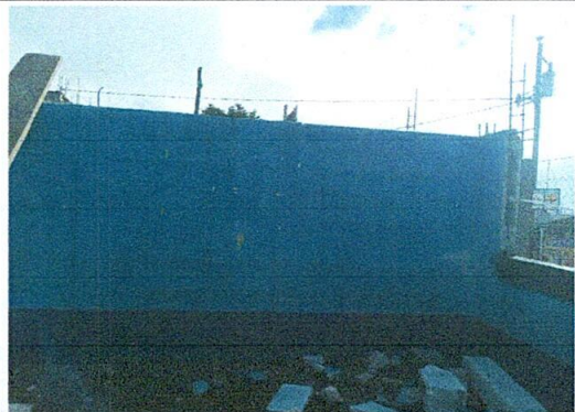
Foto 7: SUSTITUCIÓN DE ESTRUCTURA DE SOPORTE DE MADERA POR METAL
