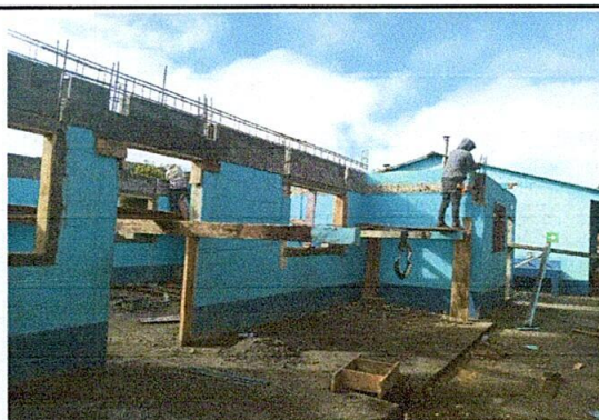
Foto 15: SUSTITUCIÓN DE ESTRUCTURA DE SOPORTE DE MADERA POR METAL
