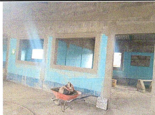
Foto 22: SUSTITUCIÓN DE 3 PUERTAS DE MADERA POR PUERTAS DE METAL
