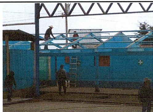
Foto 11: SUSTITUCIÓN DE ESTRUCTURA DE SOPORTE DE MADERA POR METAL
