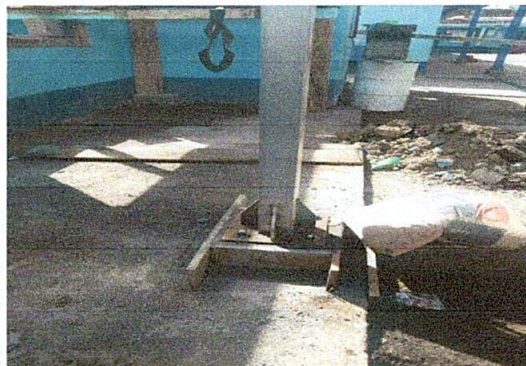
Foto 14: SUSTITUCIÓN DE ESTRUCTURA DE SOPORTE DE MADERA POR METAL
