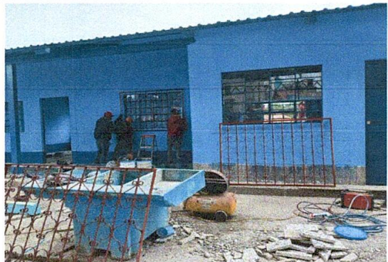
Foto 25: SUSTITUCIÓN DE VENTANAS DE MADERA POR VENTANAS DE METAL Y VIDRIO
