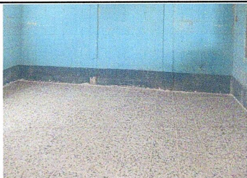
Foto 5: SUSTITUCIÓN DE PISO DE TORTA DE CONCRETO POR PISO DE GRANITO
