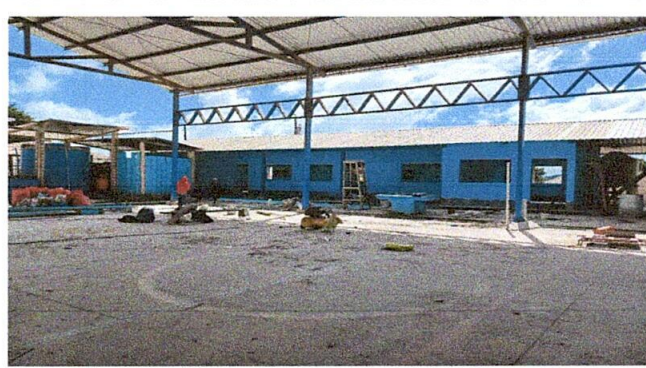
Foto 26: SUSTITUCIÓN DE VENTANAS DE MADERA POR VENTANAS DE METAL Y VIDRIO
