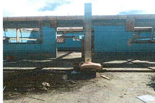
Foto 16: MEJORAMIENTO DE CERRAMIENTO EN AULAS
