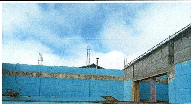
Foto 17: MEJORAMIENTO DE CERRAMIENTO EN AULAS
