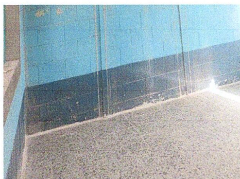
Foto 2: SUSTITUCIÓN DE PISO DE TORTA DE CONCRETO POR PISO DE GRANITO
