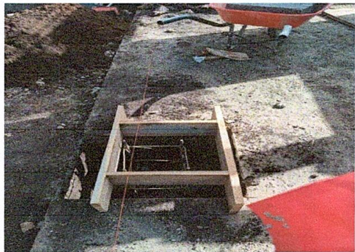
Foto 13: SUSTITUCIÓN DE ESTRUCTURA DE SOPORTE DE MADERA POR METAL
