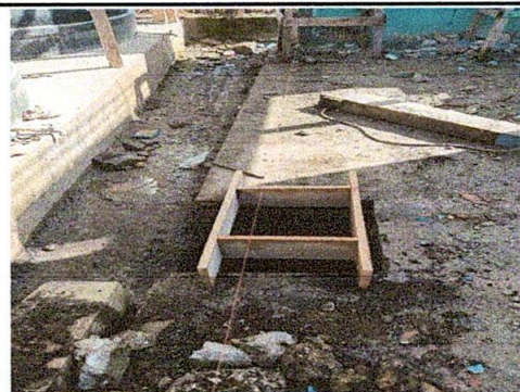
Foto 12: SUSTITUCIÓN DE ESTRUCTURA DE SOPORTE DE MADERA POR METAL
