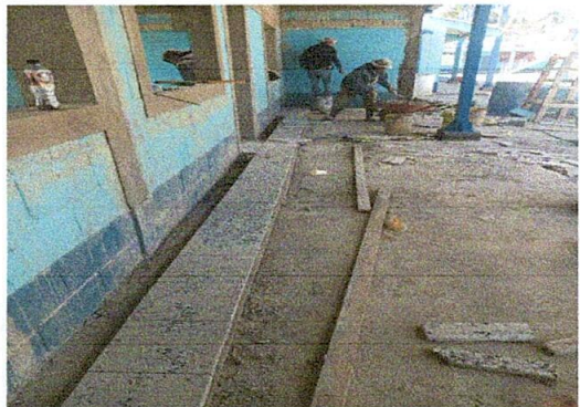
Foto 1: SUSTITUCIÓN DE PISO DE TORTA DE CONCRETO POR PISO DE GRANITO
