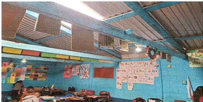
Foto7: SUSTITUCIÓN DE ESTRUCTURA DE SOPORTE DE MADERA POR METAL
