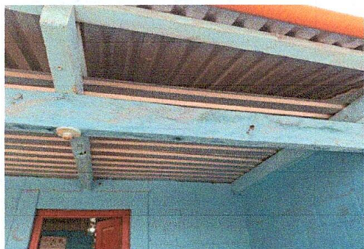
Foto 15: SUSTITUCIÓN DE ESTRUCTURA DE SOPORTE DE MADERA POR METAL
