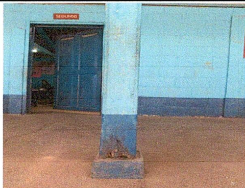
Foto 13: SUSTITUCIÓN DE ESTRUCTURA DE SOPORTE DE MADERA POR METAL
