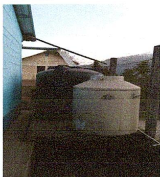
Foto 29: SUSTITUCIÓN DE DEPÓSITO DE AGUA DE 2,500 LITROS
