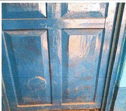
Foto 21: SUSTITUCIÓN DE PUERTAS DE MADERA POR PUERTAS DE METAL
