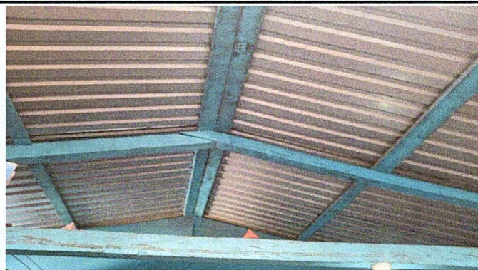
Foto 8: SUSTITUCIÓN DE ESTRUCTURA DE SOPORTE DE MADERA POR METAL
