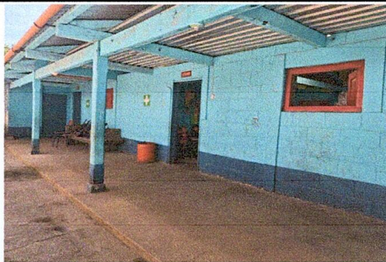
Foto 14: SUSTITUCIÓN DE ESTRUCTURA DE SOPORTE DE MADERA POR METAL
