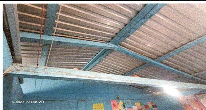
Foto 10: SUSTITUCIÓN DE ESTRUCTURA DE SOPORTE DE MADERA POR METAL
