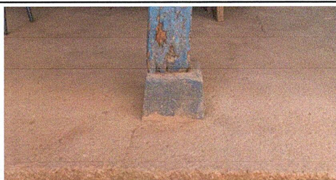
Foto 12: SUSTITUCIÓN DE ESTRUCTURA DE SOPORTE DE MADERA POR METAL
