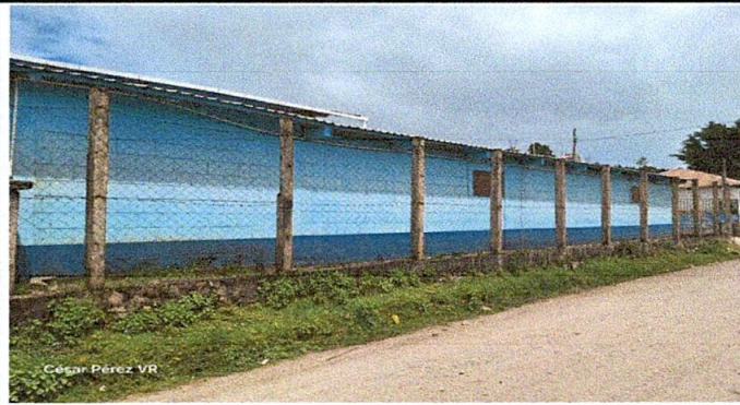
Foto 26: SUSTITUCIÓN DE VENTANAS DE MADERA POR VENTANAS DE METAL Y VIDRIO
