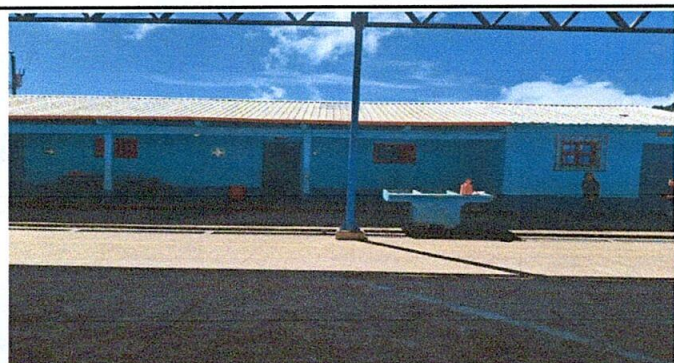
Foto 23: SUSTITUCIÓN DE VENTANAS DE MADERA POR VENTANAS DE METAL Y VIDRIO
