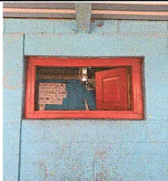
Foto 25: SUSTITUCIÓN DE VENTANAS DE MADERA POR VENTANAS DE METAL Y VIDRIO
