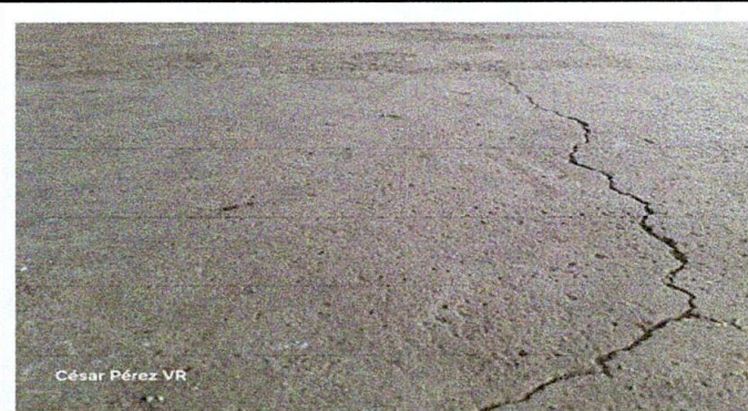
Foto 4: SUSTITUCIÓN DE PISO DE TORTA DE CONCRETO POR PISO DE GRANITO
