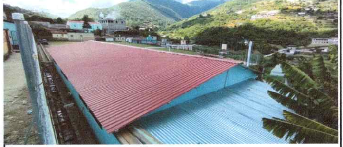
Foto 2: Sustrucción de lamina acanalada por lámina troquelada
