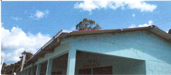
Foto1: Sustrucción de canal de PVC por metal
