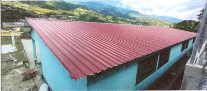
Foto 1: Sustrucción de lámina acanalada por lámina troquelada
