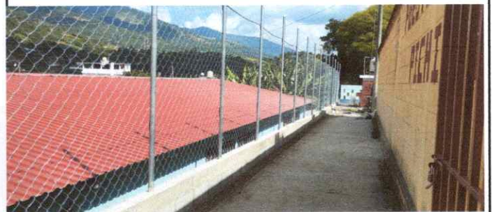
Foto 4: Reparación de tubo hg y malla galvanizada
