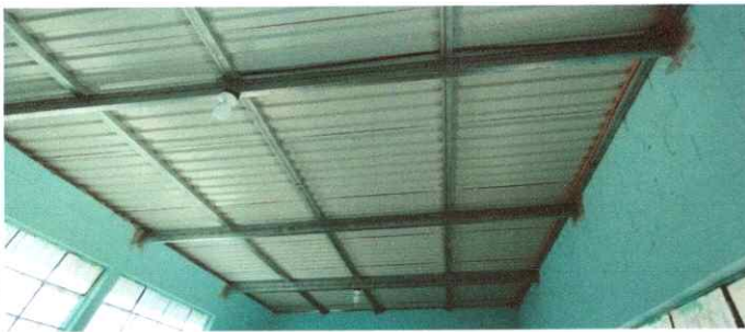
Foto 5: Sustrucción de soporte de madera por metal
