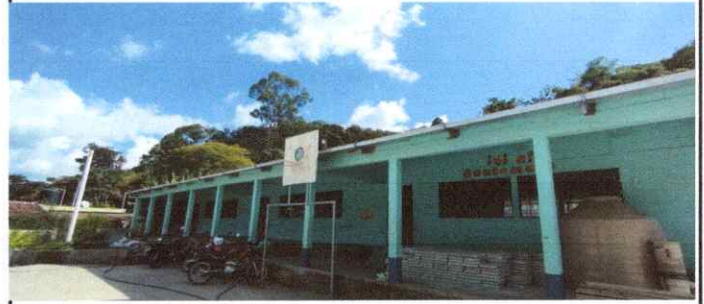
Foto 2: Sustrucción de canal de PVC por metal
