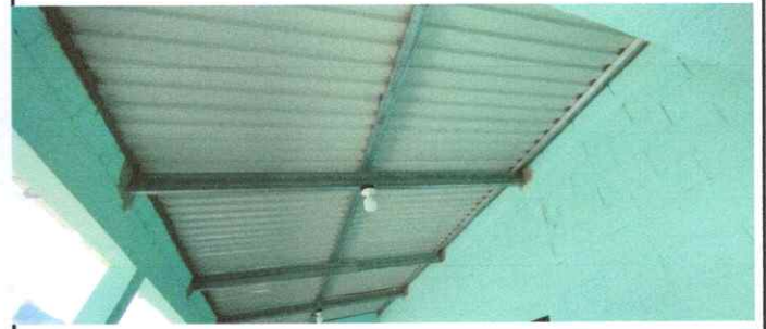
Foto 6: Sustrucción de soprte de madera por metal
