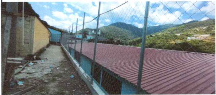
Foto 3: Reparación de tubo hg y malla galvanizada
