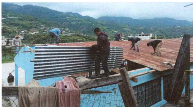
Foto1: Sustitución de lámina acanalada por lámina troquelada
