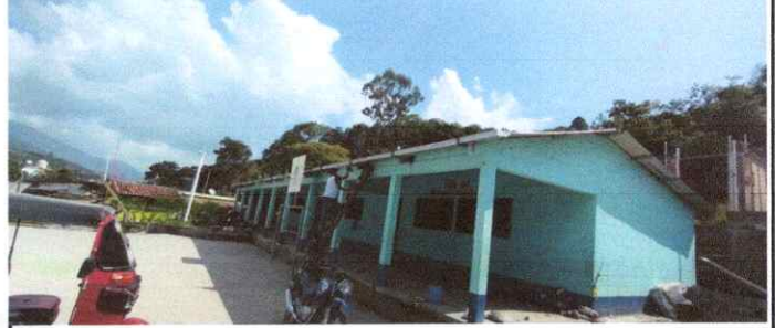
Foto 2: Sustitución de canal de PVC por metal
