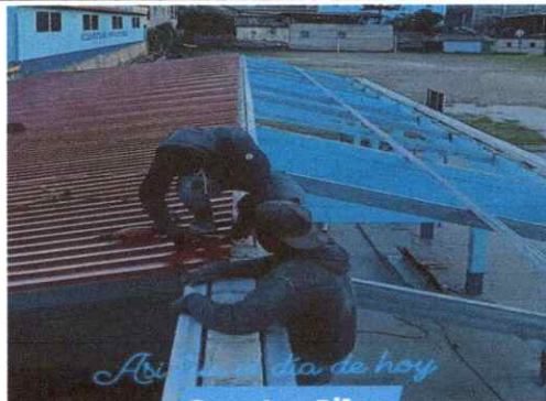
Foto 2: Sustitución de lamina acanalada por lámina troquelada
