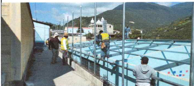
Foto 3: Reparación de tubo hg y malla galvanizada
