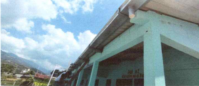
Foto1: Sustitución de canal de PVC por metal
