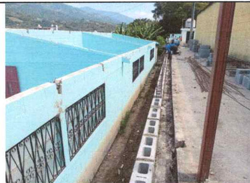
Foto 4: Reparación de tubo hg y malla galvanizada
