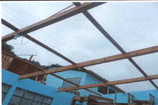
Foto 5: Sustitución de soporte de madera por metal
