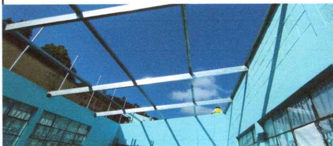
Foto 6: Sustitución de sopрте de madera por metal
