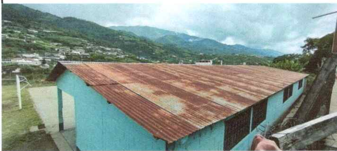
Foto 1: Sustitución de lámina acanalada por lámina troquelada
