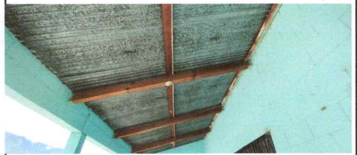
Foto 6: Sustitución de sopрте de madera por metal
