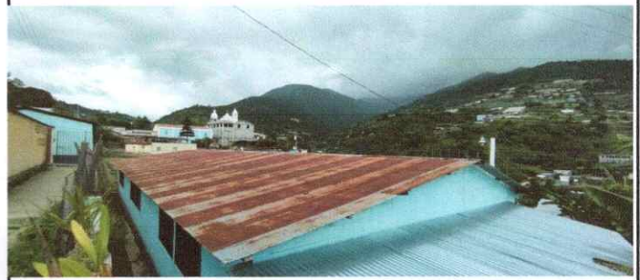
Foto 2: Sustitución de lamina acanalada por lámina troquelada
