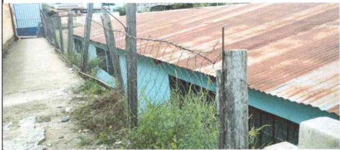
Foto 3: Reparación de tubo hg y malla galvanizada
