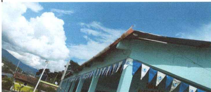
Foto1: Sustitución de canal de PVC por metal
