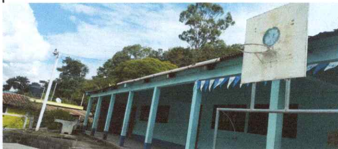
Foto 2: Sustitución de canal de PVC por metal
