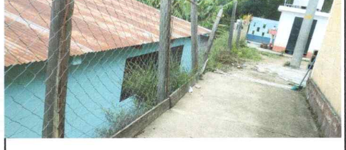
Foto 4: Reparación de tubo hg y malla galvanizada
