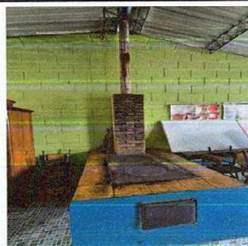
Foto 10: Sustrucción de plancha de metal de 3 hornillas
