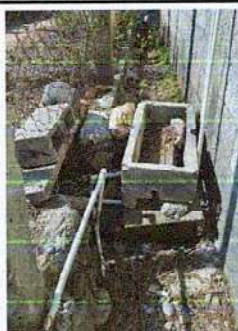
Foto 5:Sustitución de tubería línea principal de agua
