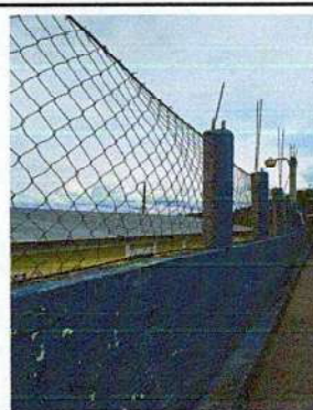
Foto 8: Sustrucción de malla galvanizada
