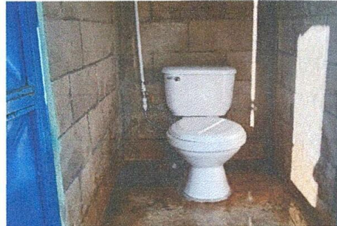
FOTO 6: Sustitución de sanitarios
