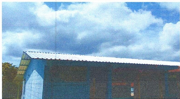
FOTO1: Sustitución de lámina por lámina troquelada y estructura
