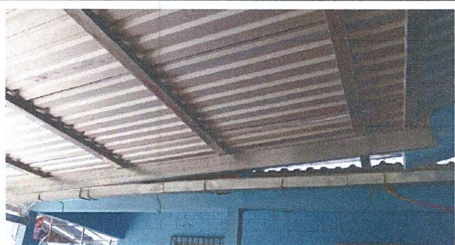
FOTO 3: Sustitución de lámina por lámina troquelada
