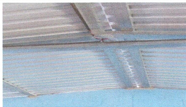
FOTO 2: Sustitución de estructura de metal por metal
