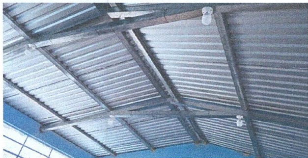
FOTO 5: Reparación de sistema eléctrico
