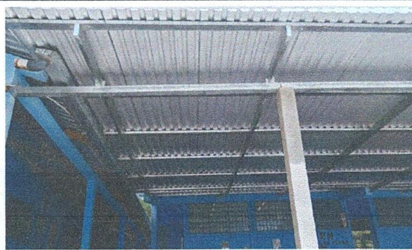
FOTO 4: Sustitución de estructura de madera por metal
