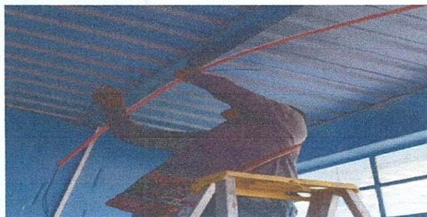
FOTO 5: Reparación de sistema eléctrico
