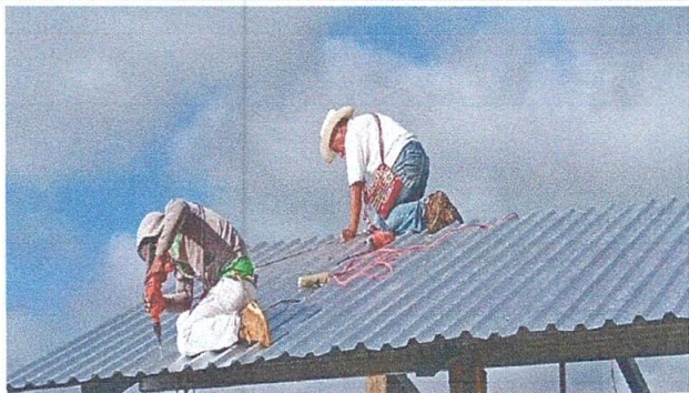
FOTO1: Sustitución de lámina por lámina troquelada y estructura
