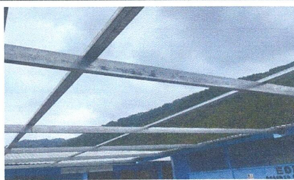
FOTO 4: Sustitución de estructura de madera por metal
