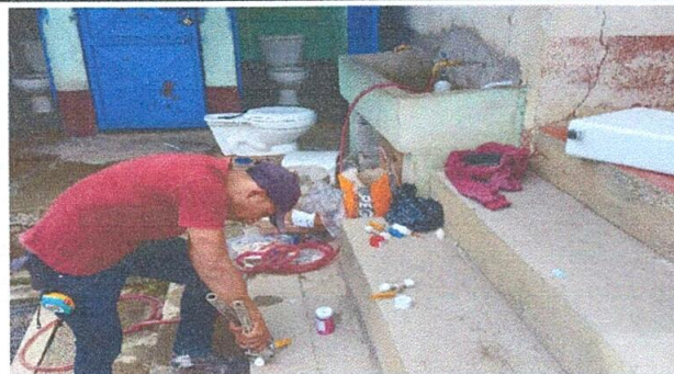
FOTO 6: Sustitución de sanitarios
