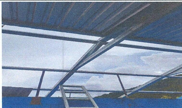
FOTO 3: Sustitución de lámina por lámina troquelada
