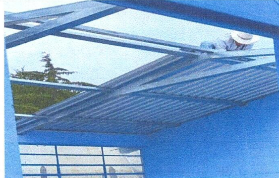
FOTO 2: Sustitución de estructura de metal por metal
