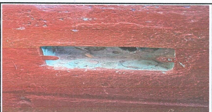
FOTO 5: Reparación de sistema electrico
