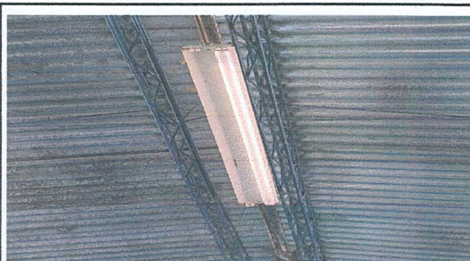
FOTO 2: Sustrución de estructura de metal por metal
