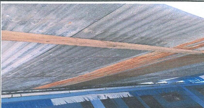
FOTO 4: Sustrución de estructura de madera por metal
