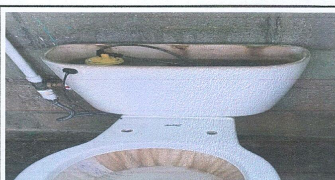
FOTO 6: Sustrución de sanitarios
