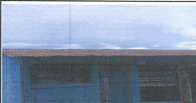
FOTO1: Sustrución de lámina por lámina troquelada y estructura
