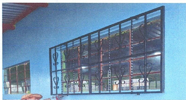
FOTO 3: Colocación de balcones de metal
