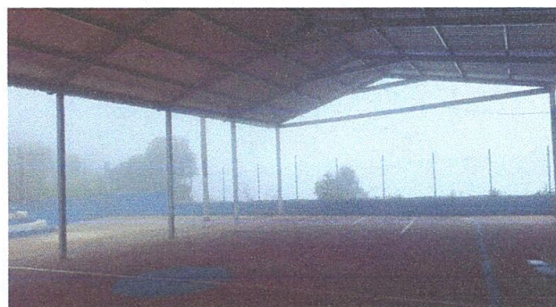
FOTO 2: Sustitución de estructura portante de madera por metal
