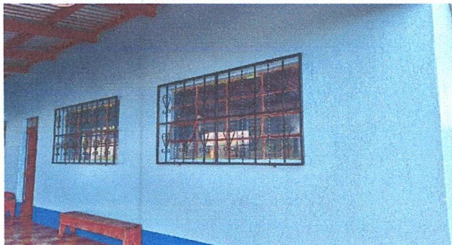
FOTO1: Sustitución de lámina por lámina troquelada
