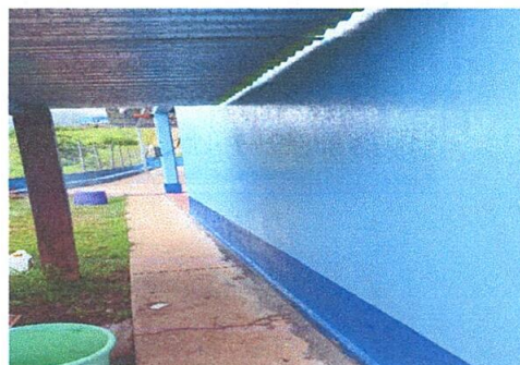
FOTO 6: Pintura en muros exteriores
