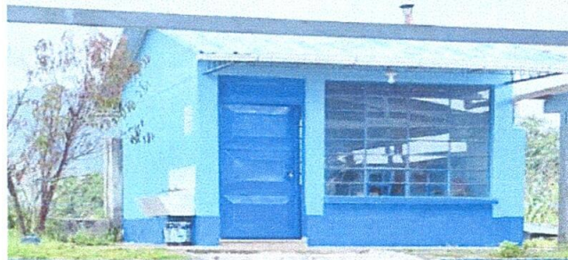
FOTO 4: Sustitución de canal de pvc
