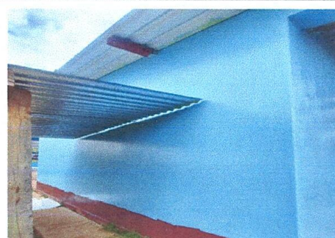
FOTO 6: Pintura en muros exteriores
