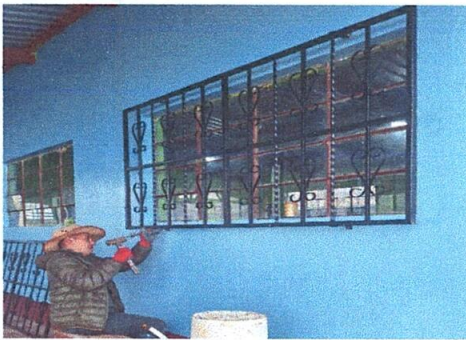
FOTO 3: Colocación de balcones de metal
