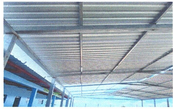
FOTO 2: Sustitución de estructura portante de madera por metal
