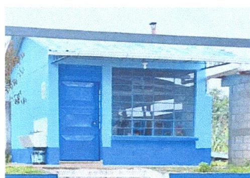
FOTO 4: Sustitución de canal de pvc
