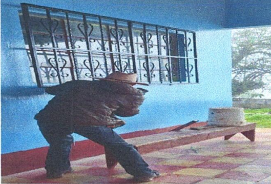
FOTO1: Sustitución de lámina por lámina troquelada
