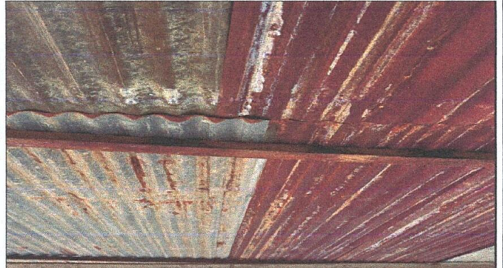
FOTO 2: Sustitución de estructura portante de madera por metal
