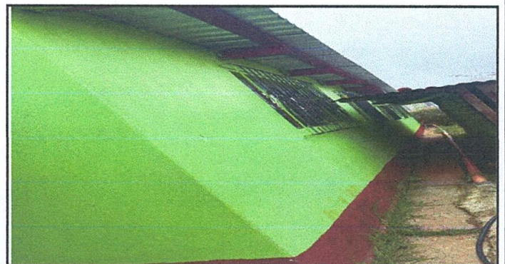
FOTO 6: Pintura en muros exteriores
