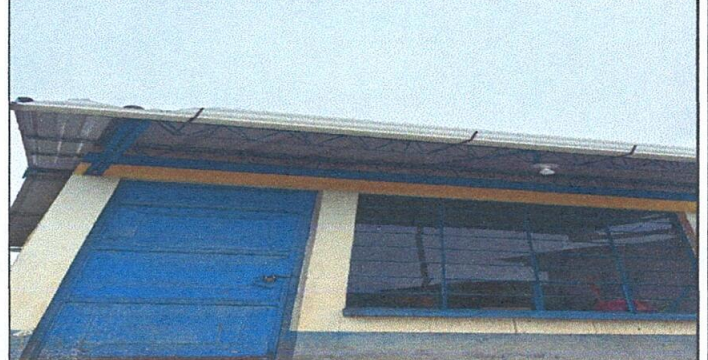
FOTO 4: Sustitución de canal de pvc
