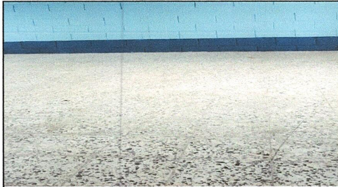
INSTALACION DE PISO GRANITO
