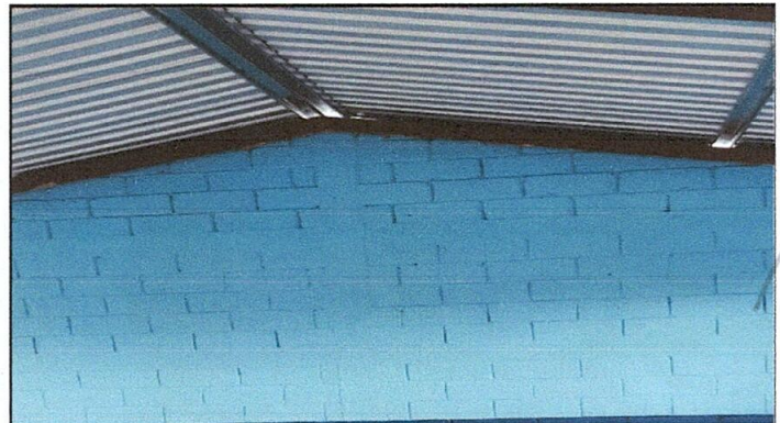
MEJORAMIENTO DE TECHO DE LAMINA
