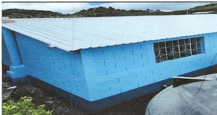
MEJORAMIENTO DE ESTRUCTURA DE TECHO
