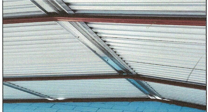
SUSTITUCION DE CUBIERTA DE LAMINA
