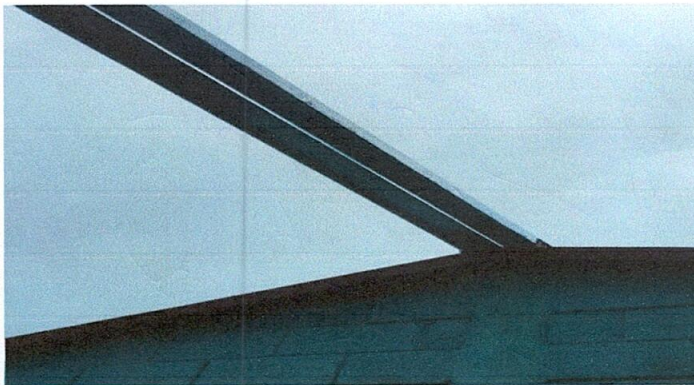
ESTRUCTURA DE TECHO
