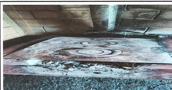
FOTO 6: Mejoramiento de cocina
