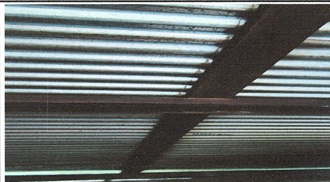
FOTO 2: Sustrución de estructura portante de lámina
