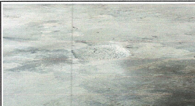
FOTO 3: Sustrución de piso por pisogranito
