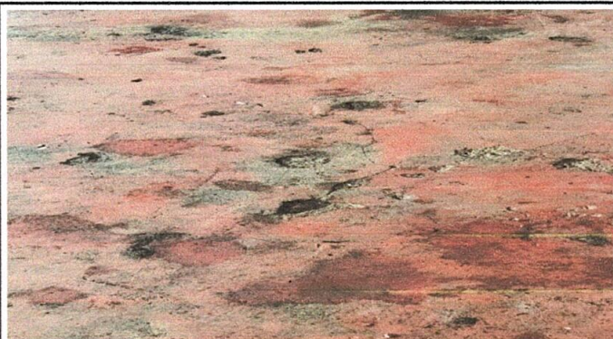
FOTO 4: Sustrución de piso por pisogranito
