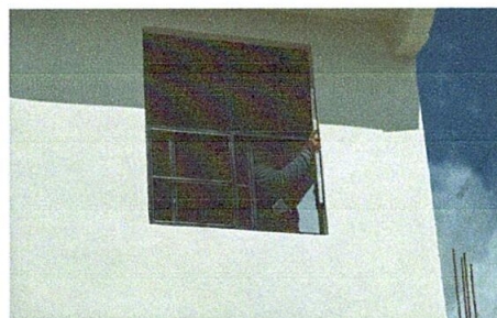
Foto 4: colocación de ventanas
