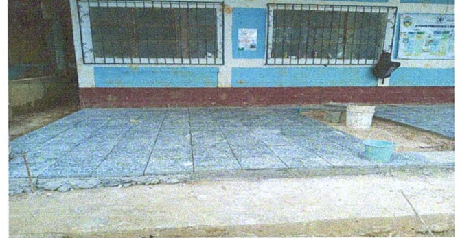
colocación del piso granito en los ambientes del primer nivel
