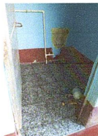
Foto 6: proceso de trabajos del baño
