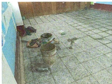
Foto 3: terminando el piso de las aulas
