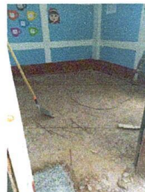
Foto 2: preparación para poner el piso
