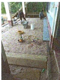
Foto 5: proceso de colocación piso del corredor
