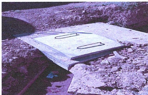
Foto 11: Sustrucci3n de tapa de drenaje, ya que actualmente tiene madera y troncos.
