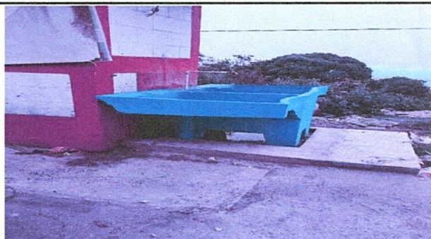
Foto 6: Sustitución de lavamanos por pilas de dos lavaderos.
