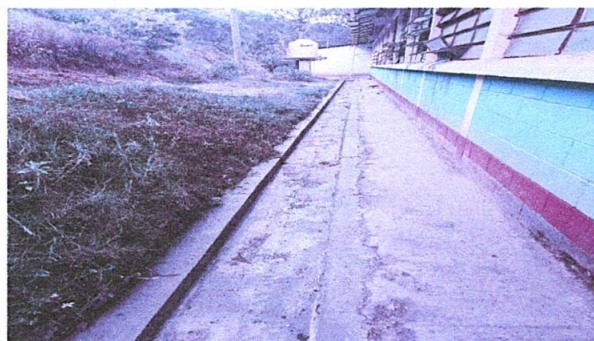
Foto 4: Reparación de cuneta.
