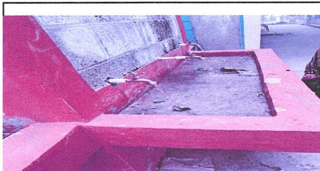
Foto 5: Sustitución de chorros plásticos a chorros de metal.
