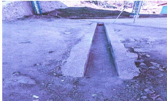
Foto 12: Reparaci3n de cunetas
