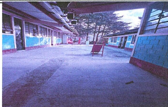
Foto1: Sustitución de losa de concreto para pasillo.
