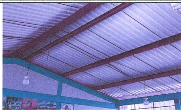
Foto 2: Sustitución de candelas por focos con plafonera normal
