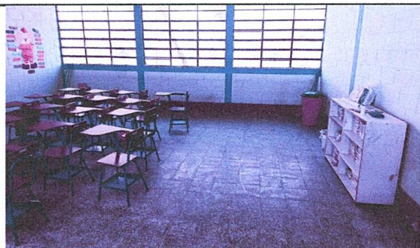
Foto 3: Sustitución de piso de cemento por piso de granito.
