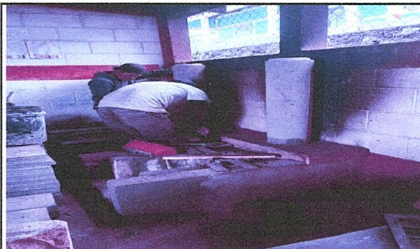
Foto 9: Sustitución de plancha rural, estan en mal estado
