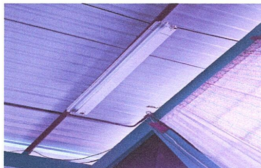
Foto 2: Sustrucción de candelas por focos con plafonera normal
