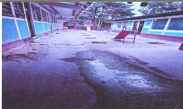
Foto 1: Sustrucción de losa de concreto para pasillo.
