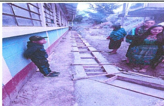
Foto 4: Reparación de cuneta.
