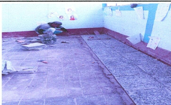
Foto 3: Sustrucción de piso de cemento por piso de granito.
