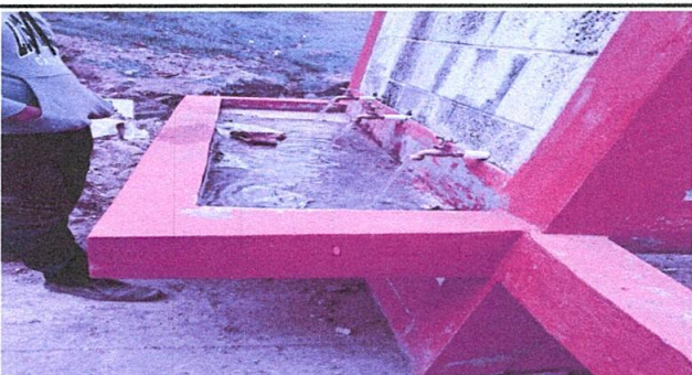
Foto 5: Sustrucción de chorros plásticos a chorros de metal.
