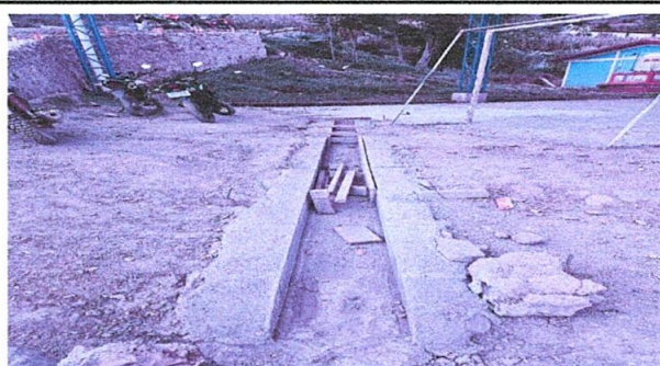
Foto 12: Reparación de cunetas
