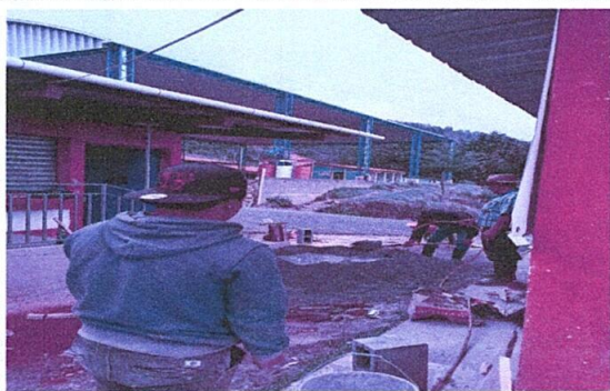
Foto 7: Sustitución de planchas de concreto de patio
