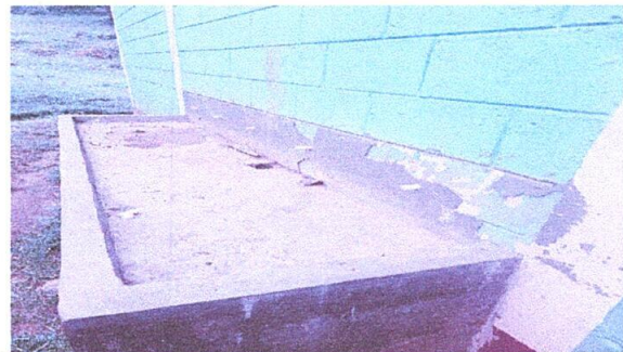
Foto 6: Sustitución de lavamanos por pilas de dos lavaderos.
