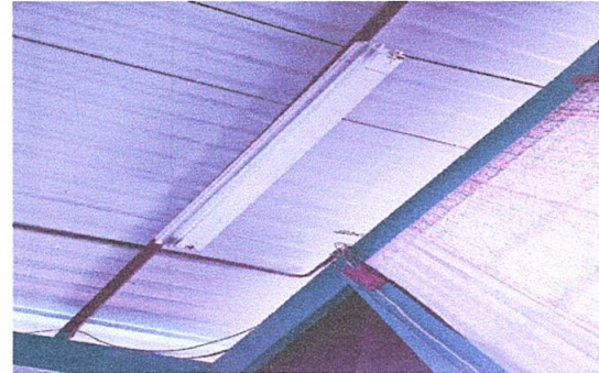
Foto 2: Sustitución de candelas por focos con plafonera normal
