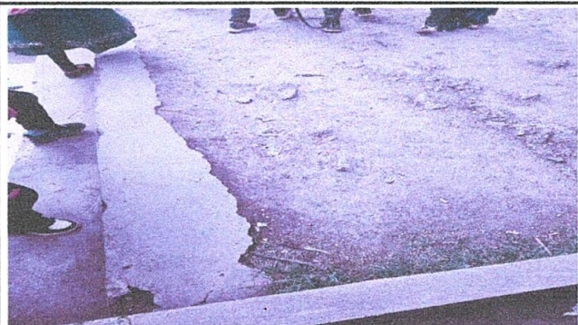
Foto 7: Sustrucción de planchas de concreto de patio
