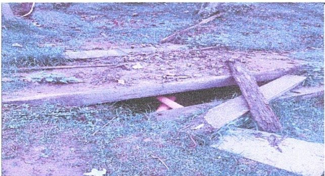
Foto 11: Sustrucción de tapa de drenaje, ya que actualmente tiene madera y troncos.
