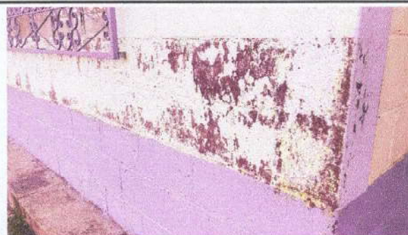
Foto 8: Pintura de edificio interior y exterior.
