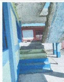
Foto 6: Mejoramiento de barandas en las gradas del segundo nivel.
