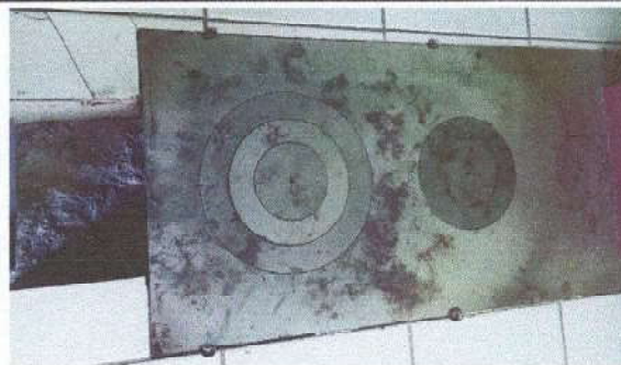
Foto 2: Sustitución de planchas en estufas rural.
