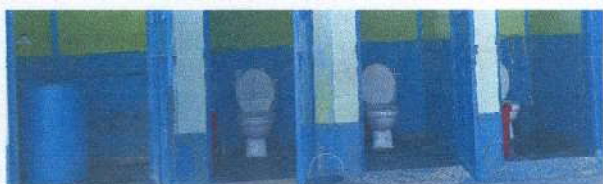
Foto 5: Instalación de azulejo en paredes de baños y mingitorio.
