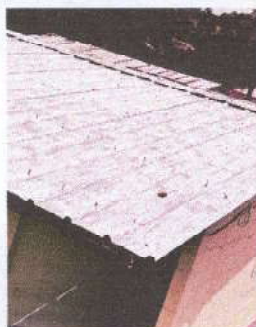
Foto 11: Sustitución de techo por lámina troquelada
