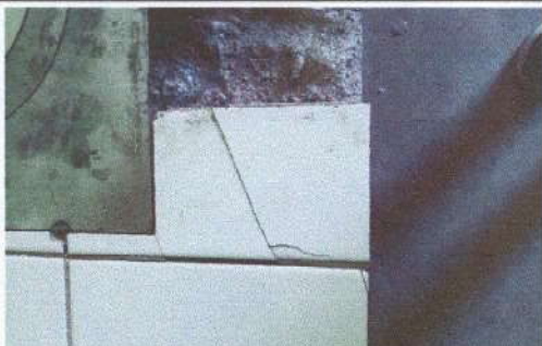
Foto 6: Reparación de estufas rural.
