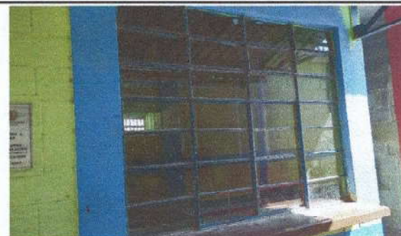
Foto 4: Sustitución de ventanal por persiana.
