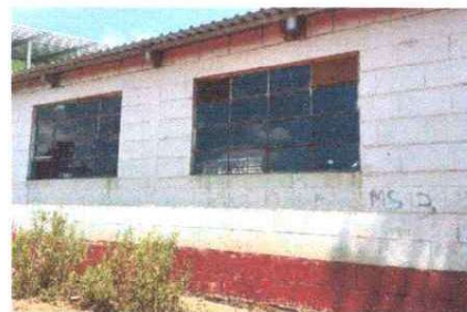
SUSTITUCION DE VENTANAS
