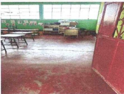
SUSTITUCION DE PISO
