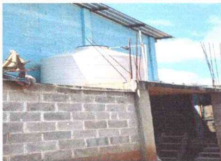
SUSTITUCION DE DEPOSITO DE AGUA
