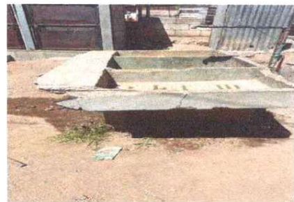
SUSTITUCION DE PILA DE CONCRETO
