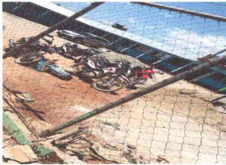
REPARACION DE MURO PERIMETRAL
