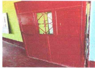
SUSTITUCION DE PUERTAS
