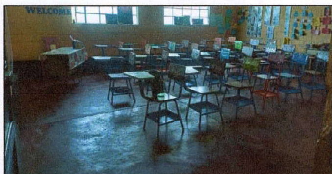
Foto 5: Sustitución de piso de granito
