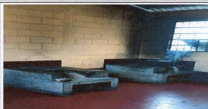
Foto 2: Sustitución de mesa de madera por una de concreto. Sustitución de estufa rural (completa) incluye chimenea y plancha de metal.
