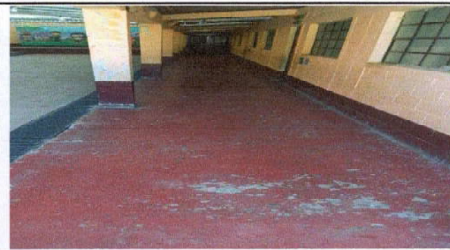
Foto 4: Sustitución de piso de granito.
