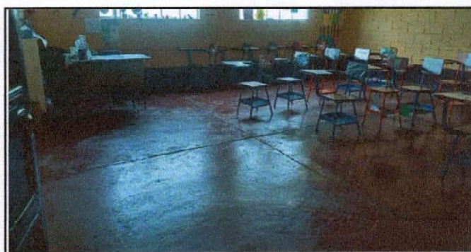
Foto 6: Sustitución de piso de granito.
