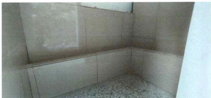
Foto 7: Mejoramiento de azulejo de paredes
