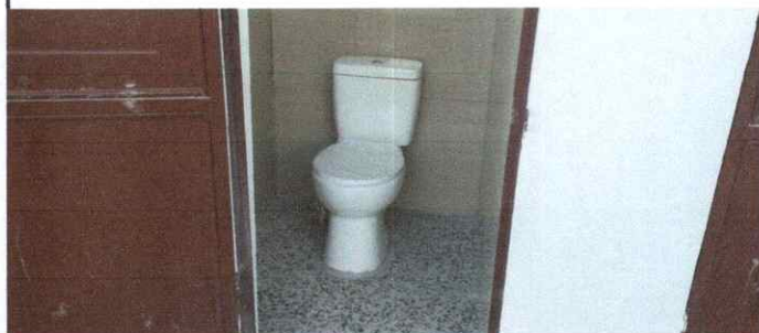
Foto 8: Sustitución de inodoro
