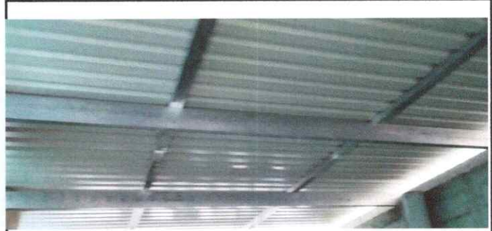
Foto 2: Sustrucción de estructuras de soporte de madera por metal
