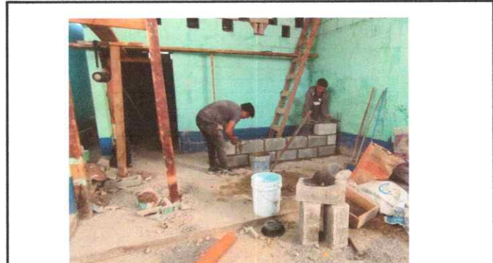
Foto 4: Sustrucción de mesa de madera por mesa de concreto de 2.5 mts por 1 m.
