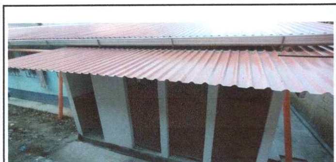
Foto 5: Sustrucción de lámina duralita por lamina troquelada calibre 26
