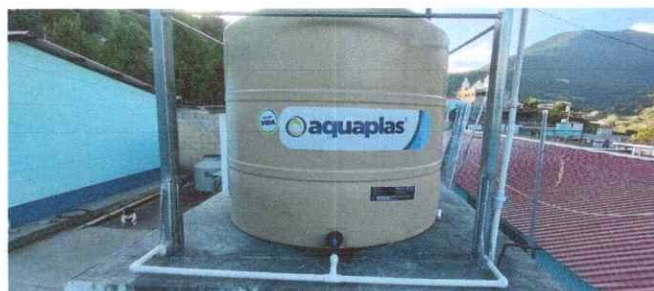
Foto 10: Sustitución de depósito de agua 2,500 lt.
