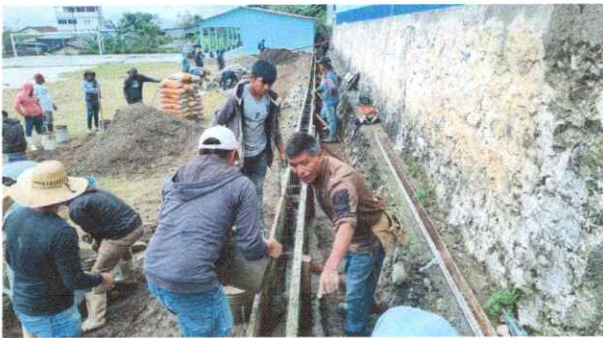
Foto 11: Reparación de cuneta de concreto.
