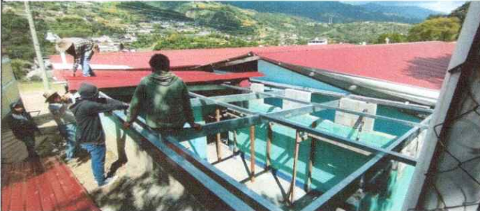
Foto1: Sustitución de cubieto de teja de barro por lamina troquelada calibre 24
