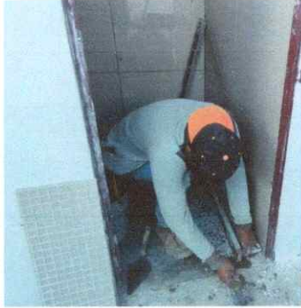
Foto 7: Mejoramiento de azulejo de paredes
