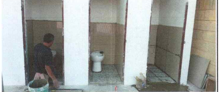
Foto 8: Sustitución de inodoro
