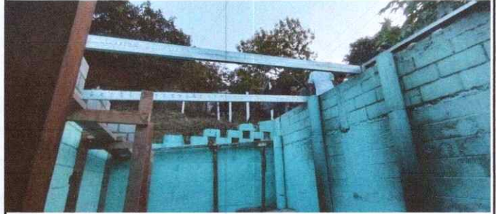
Foto 2: Sustitución de estructuras de soporte de madera por metal
