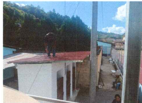
Foto 6: Sustitución de lámina acanaladaa por lámina troquelada calibre 26
