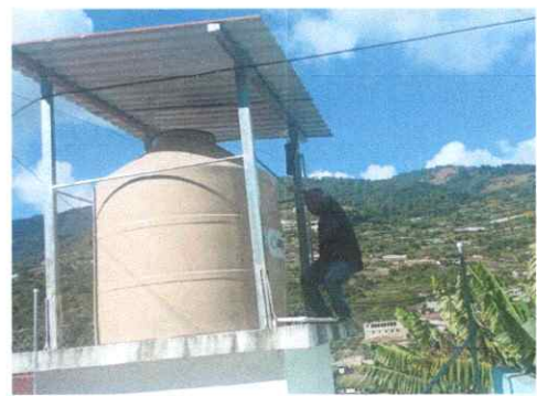
Foto 10: Sustitución de depósito de agua 2,500 lt.
