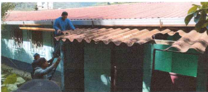
Foto 5: Sustitución de lámina duralita por lamina troquelada calibre 26
