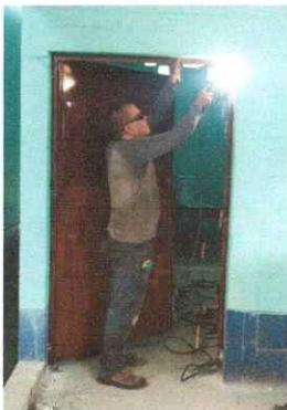
Foto 3: Sustitución de puerta de madera po puerta de metal de 1.95 mts. Por 1 m.
