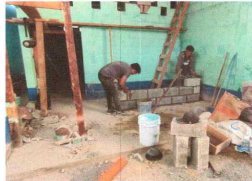
Foto 4: Sustitución de mesa de madera por mesa de concreto de 2.5 mts por 1 m.
