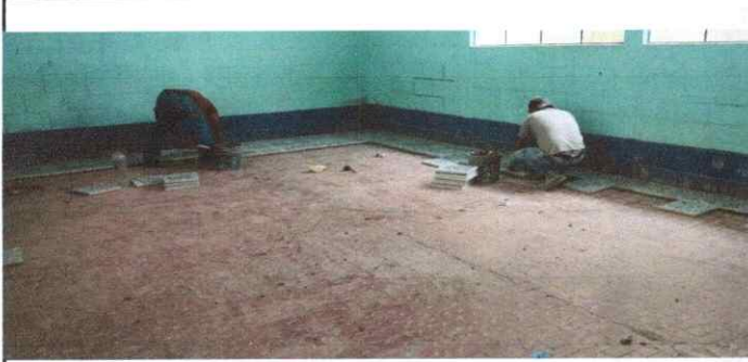
Foto 9: Sustitución de piso de concreto por piso de granito
