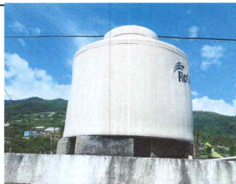
Foto 10: Sustitución de depósito de agua 2,500 lt.
