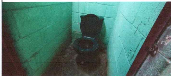
Foto 8: Sustitución de inodoro
