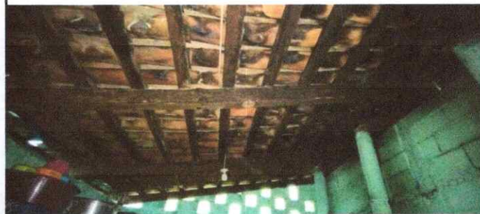
Foto 2: Sustrucción de estructuras de soporte de madera por metal
