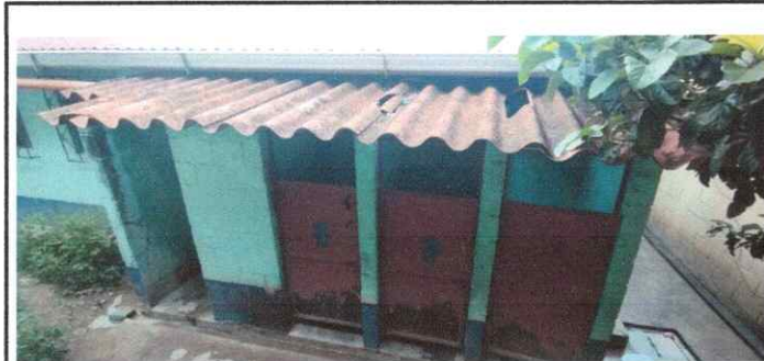
Foto 5: Sustrucción de lámina duralita por lámina troquelada calibre 26
