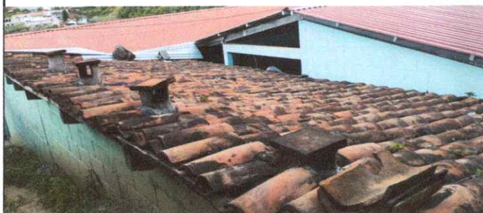
Foto 1: Sustrucción de cubierta de teja de barro por lámina troquelada calibre 24
