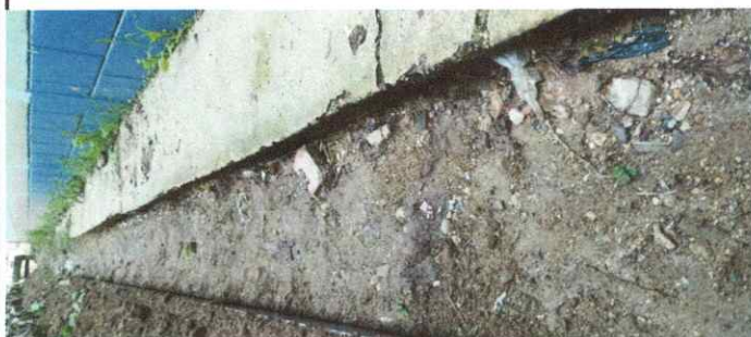
Foto 11: Reparación de cuneta de concreto
