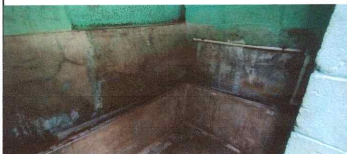
Foto7: Mejoramiento de azulejo de paredes
