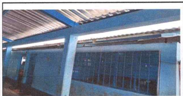
FOTO 4: SUSTITUCION DE CANAL DE METAL POR CANAL DE METAL, PESTANTES Y COLOCACION DE TUBERIAS DE AGUA PLUVIAL
