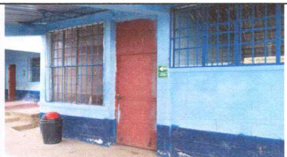
FOTO 4: MANTENIMIENTO A ESTRUCTURA DE PUERTAS Y MEJORAMIENTO DE PUERTAS DE METAL (0.73M X 0.40M)
