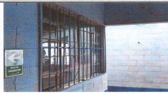
FOTO 2: MANTENIMIENTO A BALCONES
