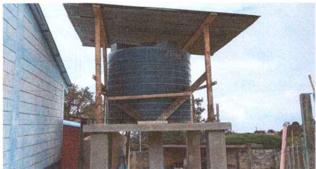
FOTO 6: SUSTITUCION DE DEPOSITO DE AGUA, Y SUS ACCESORIOS
