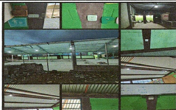
Foto 4: REPARACION DEL SISTEMA ELECTRICO
