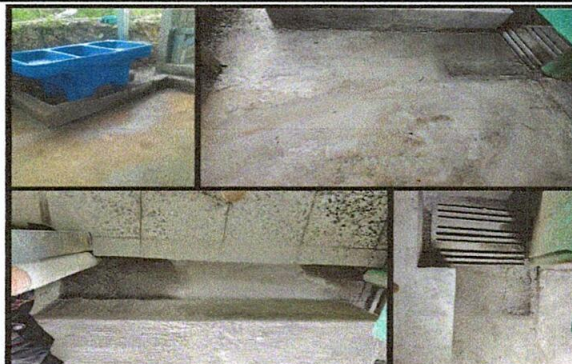
Foto 2: REPARACION CUNETA DE CONCRETO
