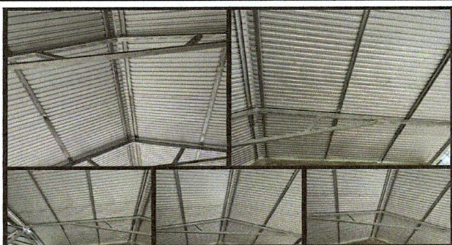
Foto 5: CUBIERTA DE LAMINAS: SUSTITUCIÓN DE LAMINAS
