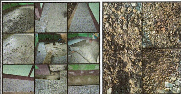
Foto1: SUSTITUCIÓN DE PISO DE GRANITO
