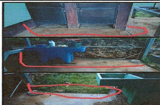
Foto 2: REPARACION CUNETA DE CONCRETO
