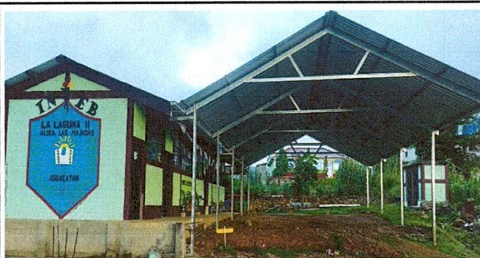
Foto 5: CUBIERTA DE LAMINAS: SUSTITUCIÓN DE LAMINAS
