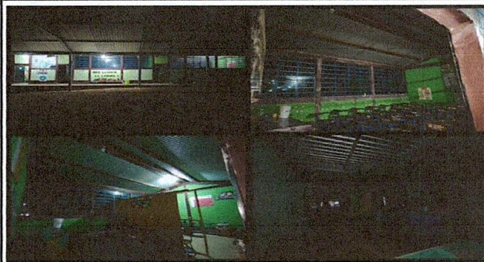
Foto 4: REPARACION DEL SISTEMA ELECTRICO
