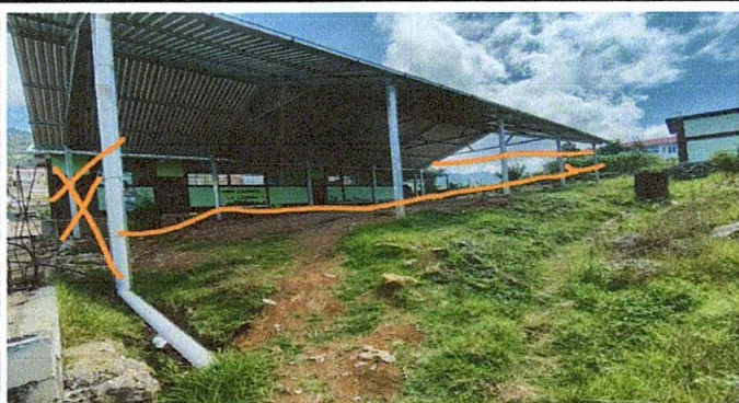
Foto 3: MUROS PERIMETRALES, MEJORAMIENTO MALLA GALVANIZADA Y TUBO HG
