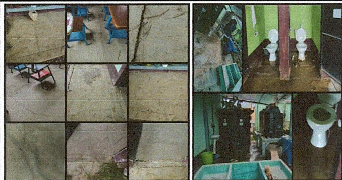
Foto 1: SUSTITUCIÓN DE PISO DE GRANITO
