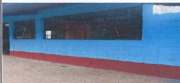
Foto1: MEJORAMIENTO DE BALCONES EN AREA DE VENTANAS (FABRICACION E INSTALACION)
