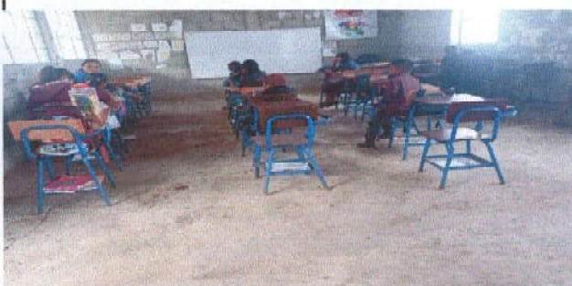
Foto 3:SUSTITUCION DE PISO DE CONCRETO EN MAL ESTADO A PISO CERMICO GRANITO
