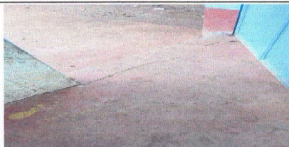
Foto 5:SUSTITUCION DE PISO DE CEMENTO LIQUIDO A PISO GRANITO
