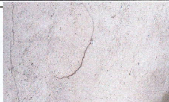
Foto 4: SUSTITUCION DE PISO DE CONCRETO EN MAL ESTADO A PISO CERMICO GRANITO
