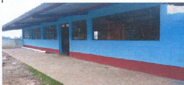
Foto 2: MEJORAMIENTO DE BALCONES EN AREA DE VENTANAS (FABRICACION E INSTALACION)
