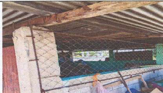
Foto 4: Elaboración, sustrución e instalación de ventana con vidrio y malla mosquitera
