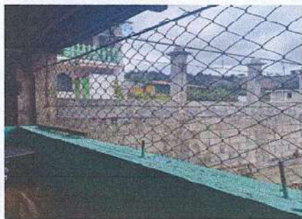
Foto 7: Mejoramiento de block de cocina
