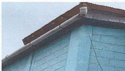
Foto 8: Sustitución de canal de PVC por canal de metal
