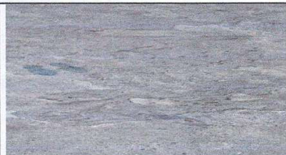
Foto 5: Sustrución de piso de aula por piso de granito
