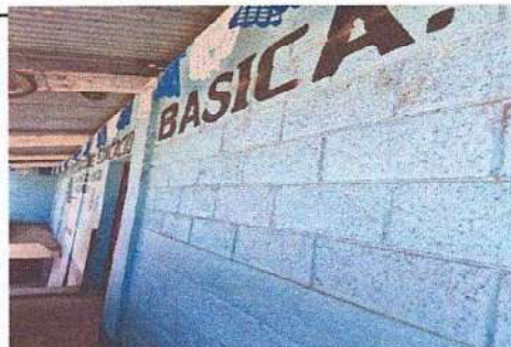
Foto 6: Pintura en muros exteriores
