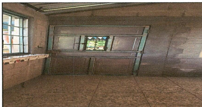
Foto 5: Sustitución de piso finalizada
