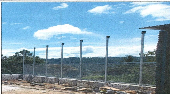
Foto1: Muro perimetral finalizada
