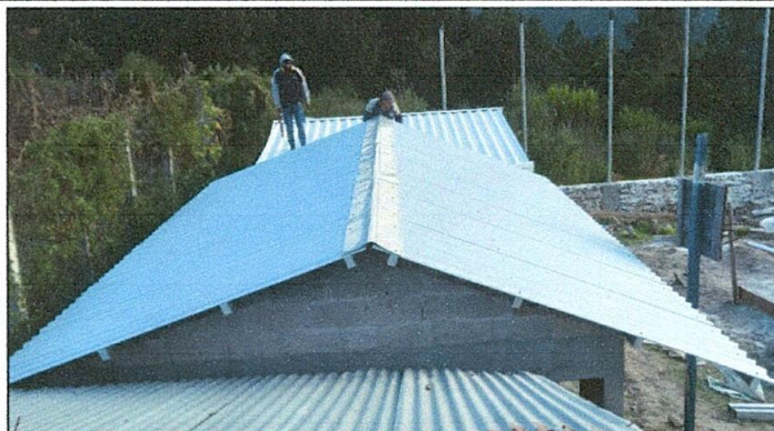
Foto 2: Estructura de techo finalizado
