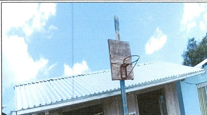
Foto1: Cubierta de lamina en finalizado
