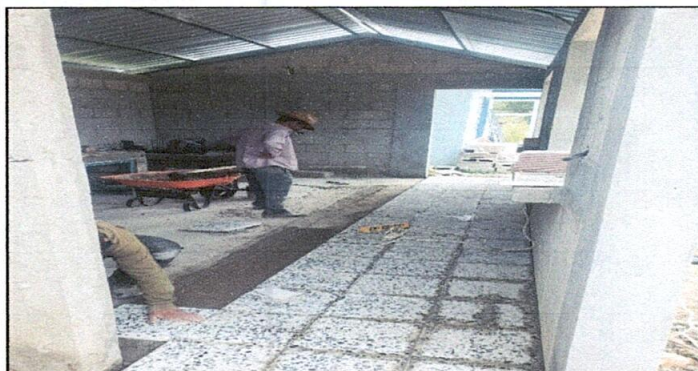
Foto 5: Sustitución de piso en finalizar
