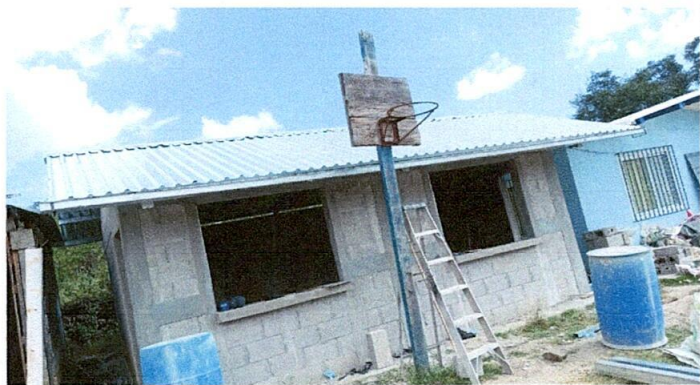
Foto 4: Ventanas en proceso de finalizar
