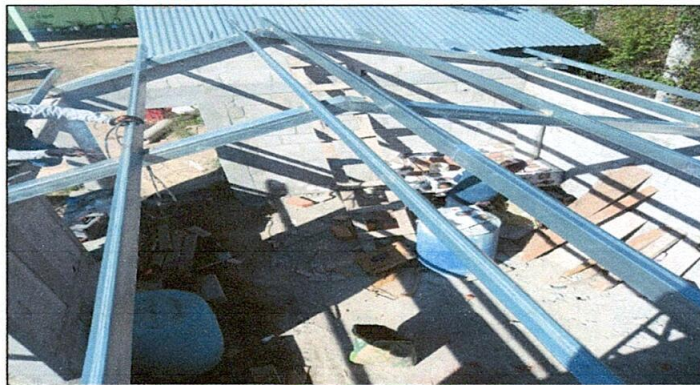
Foto 2: Estructura de techo en proceso
