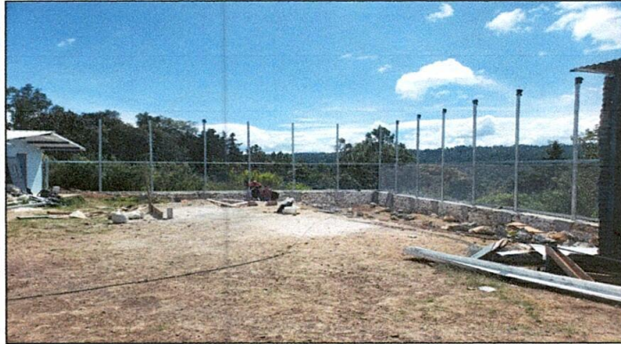
Foto1: Muro perimetral en proceso de finalizar
