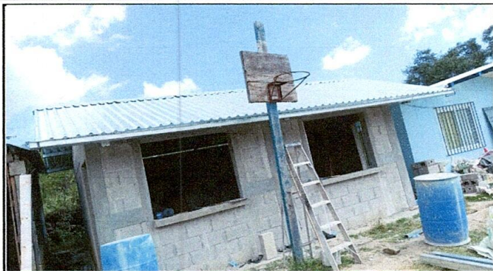
Foto1: Cubierta de lamina en proceso
