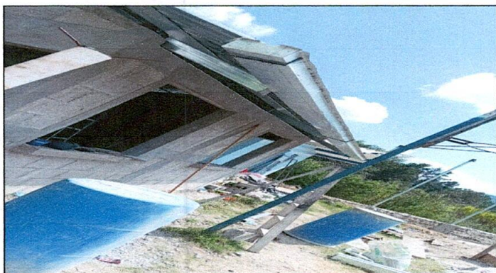
Foto 3: Canal y bajada de agua en proceso
