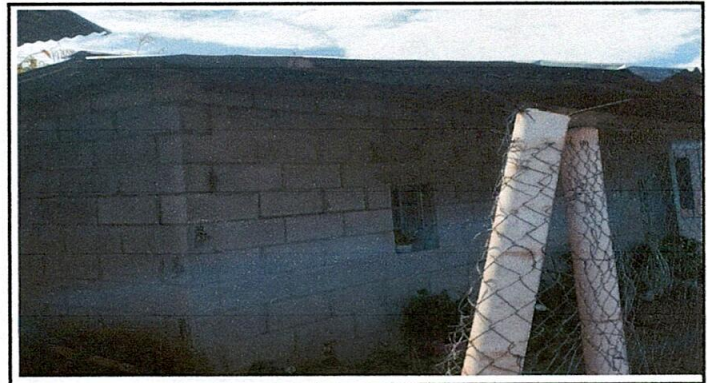
Foto 4: sustitución de canales y bajadas de agua pluvial
