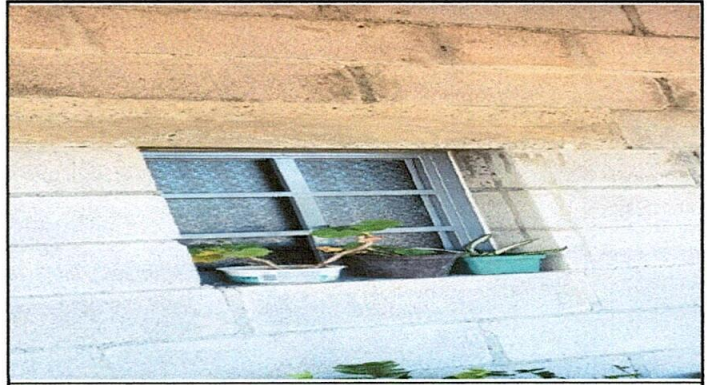
Foto 2: Sustrucción de ventana
