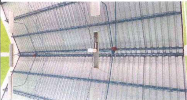
Foto 3: Ducto electrico y accesorios para aula 3
