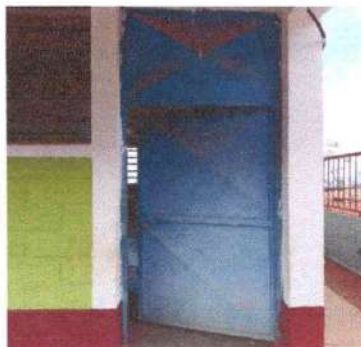
Foto 4: Pintura de puerta para aula tres
