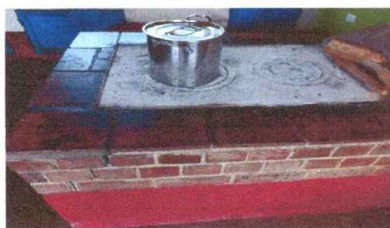
Foto 2: reparacion de pollo y sustitucion de plancha
