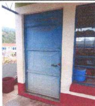
Foto 5: Pintura de puerta para cocina
