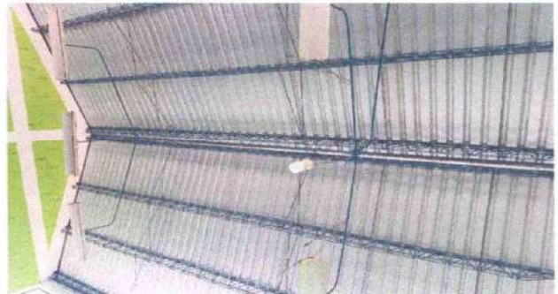
Foto 2: Ducto electrico y accesorios para aula 2
