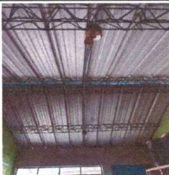
Foto 5: Ducto electrico y accesorios para cocina
