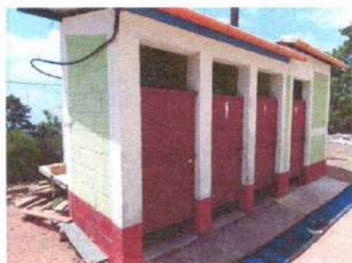
Foto 5 pintura de paredes de interior y exterior baños
