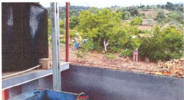
Foto1: induccion de agua y tuberia para la cocina
