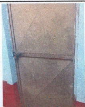
Foto 5: MANTENIMIENTO PUERTA DE BODEGA
