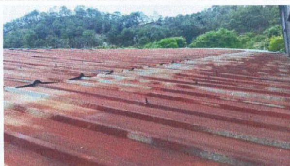
Foto 1: SUSTITUCIÓN DE LAMINA EN AULA 2 y 3
