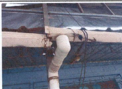
Foto 5: SUSTITUCIÓN DE BAJADA DE AGUA PLUVIAL EN CORREDOR DE AULA 4 Y 5
