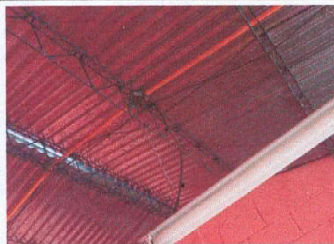
Foto 4: REPARACION DE SISTEMA ELECTRICO 3
