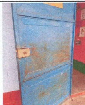
Foto 4: MANTENIMIENTO PUERTA AULA 5
