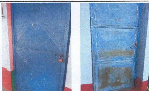
Foto 3: MANTENIMIENTO PUERTAS AULA 3 Y 4
