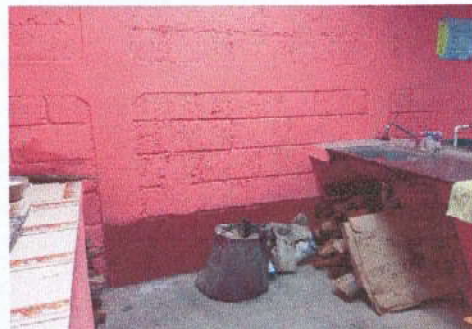
Foto 2: ESPACIO PARA PILA DE CEMENTO DE DOS LAVADEROS DENTRO DE LA COCINA
