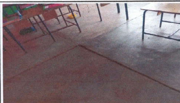
Foto 4: SUSTITUCIÓN DE PISO TORTA POR PISO GRANITO EN AULA 5
