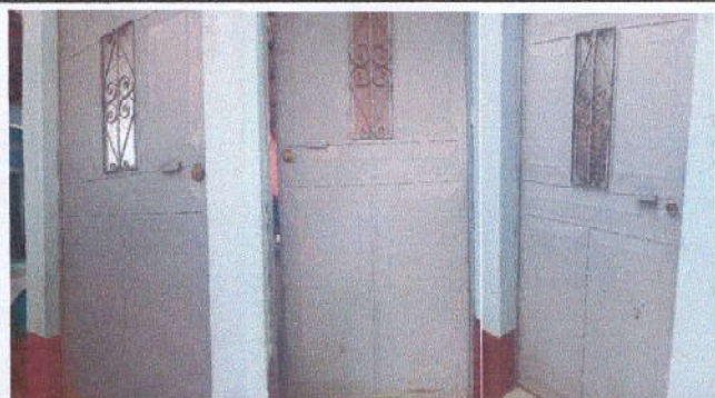
Foto 1: MANTENIMIENTO DE PUERTAS DE COCINA
