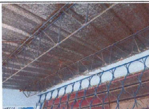
Foto 3: SUSTITUCIÓN DE SOPORTE DE TECHO EN AULA 2 Y 3.
