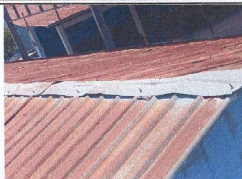
Foto 2: SUSTITUCIÓN DE CAPOTE DE AULA 2 y 3
