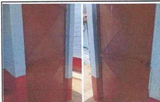
Foto 6: MANTENIMIENTO PUERTAS DE BAÑOS
