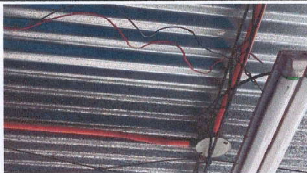
Foto 3: REPARACION DE SISTEMA ELECTRICO AULA 2
