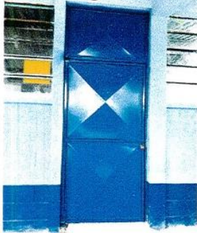
Foto 1: Mantenimiento a estructura (lijado, aplicación de pintura)
