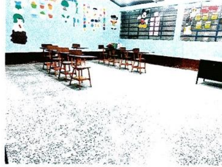
Foto 2: Sustitución de piso de granito
