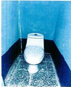
Foto 3: Sustitución de inodoro
