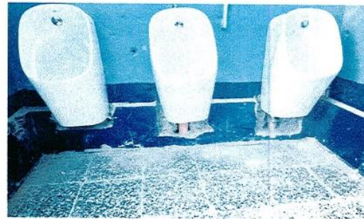
Foto 4: Sustitución de mingitorios
