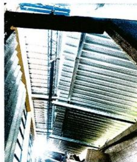
Foto 8: Sustrucción de Estructura de soporte de metal por metal
