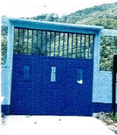
Foto 5: Mantenimiento a portón de metal
