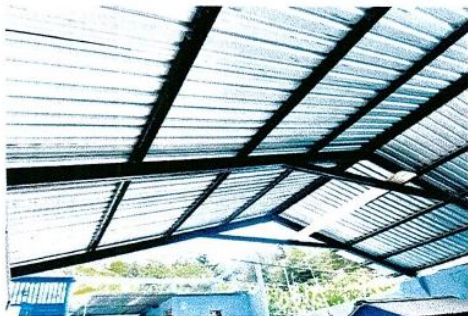
Foto7: Sustrucción de lámina por lámina troquelada aluzinc calibre 26
