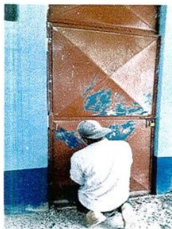
Foto1: Mantenimiento a estructura (lijado, aplicación de pintura)
