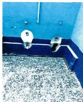
Foto 4: Sustitución de mingitorios
