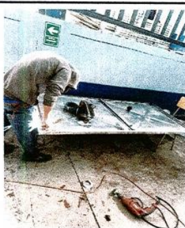
Foto 5: Mantenimiento a portón de metal
