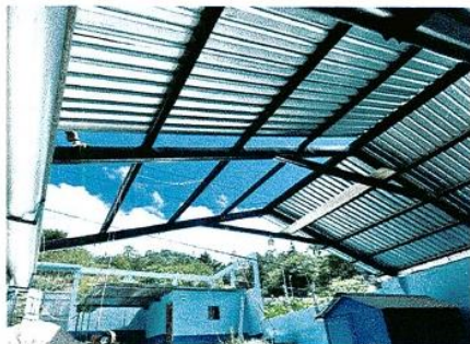
Foto7: Sustrucción de lámina por lámina troquelada aluzinc calibre 26
