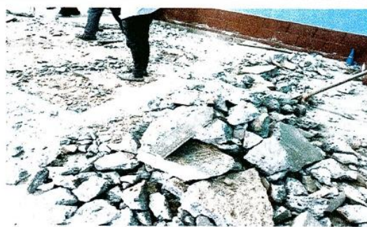
Foto 2: Sustitución de piso de granito
