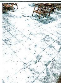
Foto 2: Sustitución de piso de granito
