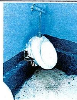
Foto 4: Sustitución de mingitorios
