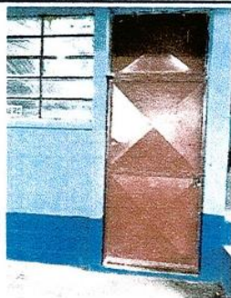
Foto 1: Mantenimiento a estructura (lijado, aplicación de pintura)
