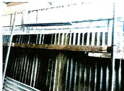
Foto 8: Sustitución de estructura de soporte de metal por metal
