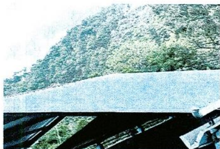
Foto7: Sustitución de lámina por lámina troquelada alizinc calibre 26
