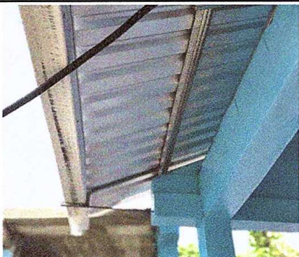
Sustitución de canal de pvc
