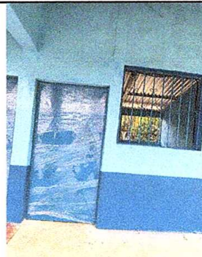
Sustitución de 4 puertas (2.10m * 1.00m )
