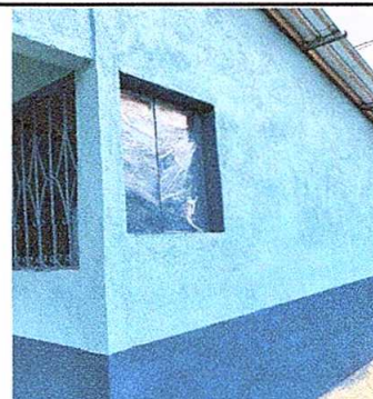
Sustitución de ventanas de madera por metal mas vidrio (1m*1.20m)
