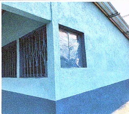
Sustitución de balcones de metal (1.20*1.95)
