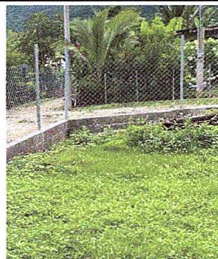
Reparación de tubo hg y malla galvanizada
