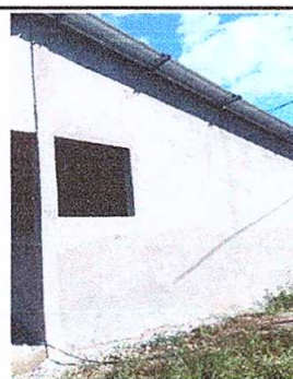
Sustitución de ventanas de madera por metal mas vidrio (1m*1.20m)
