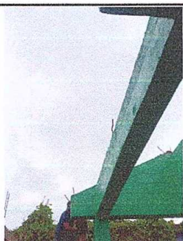
Sustitución de canal de pvc
