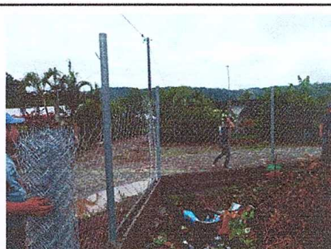
Reparación de tubo hg y malla galvanizada
