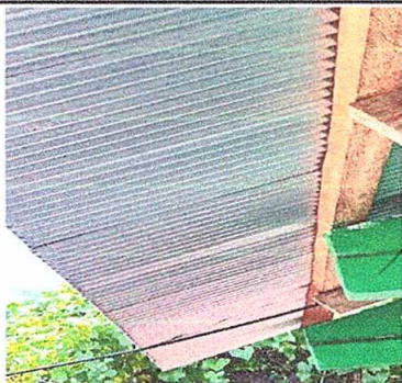
Sustitución de canal de pvc
