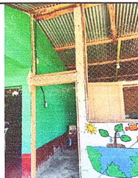
Sustitución de 4 puertas (2.10m * 1.00m)
