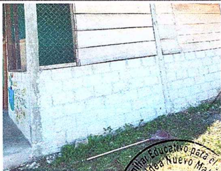
Pintura en muros exteriores e interiores
